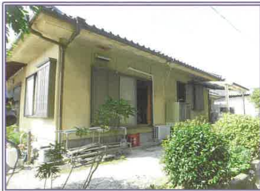
横側 近景 ・ 物件2の建物（居宅）
