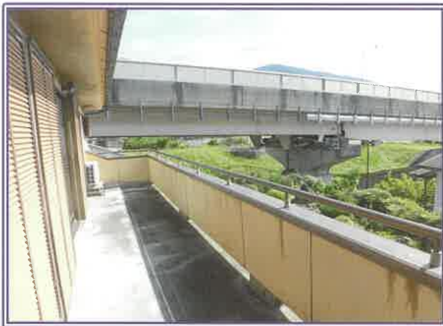
2階 バルコニー（物件2・居宅）
