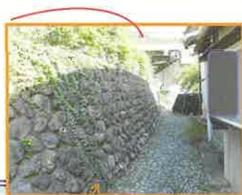
南側隣地との境界付近 （石垣上が本件敷地）
