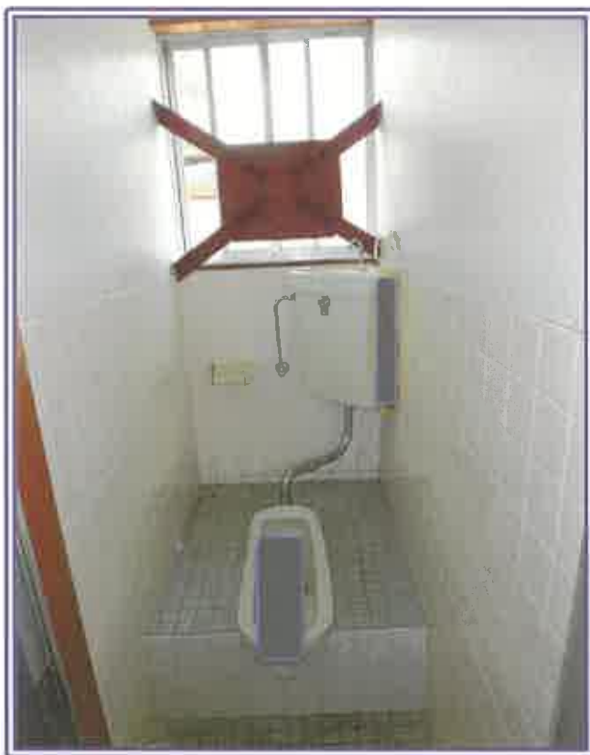
1階 作業場内トイレ（物件3・主たる建物）
