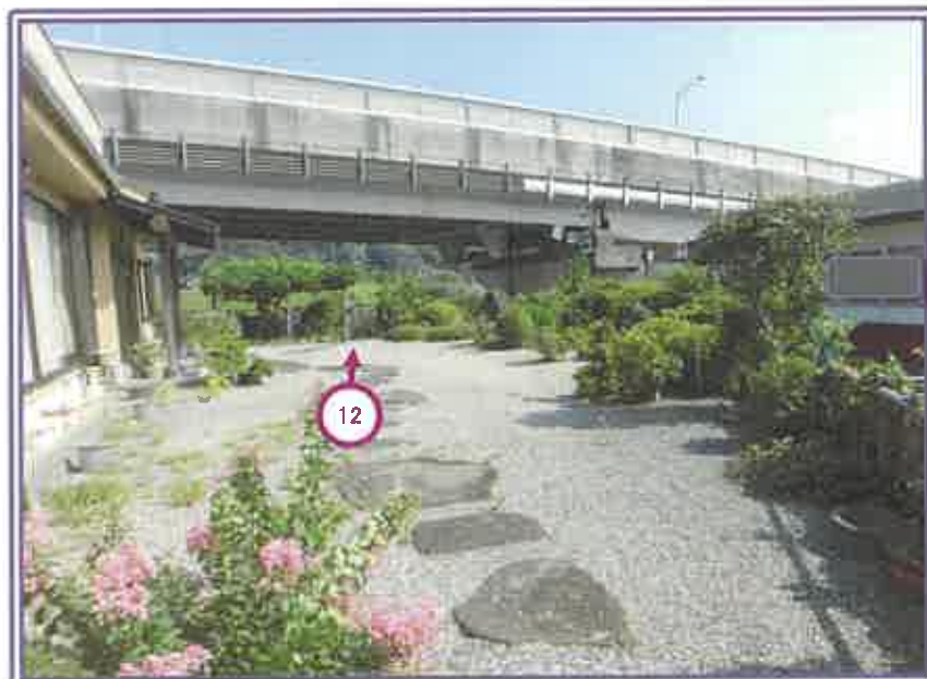
高架橋（国道）側敷地の状況
