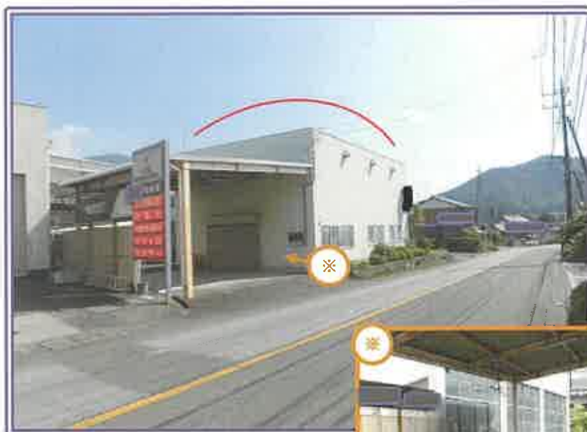
町道との接道状況
