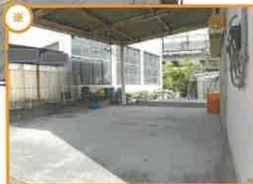
雨除下の状況
