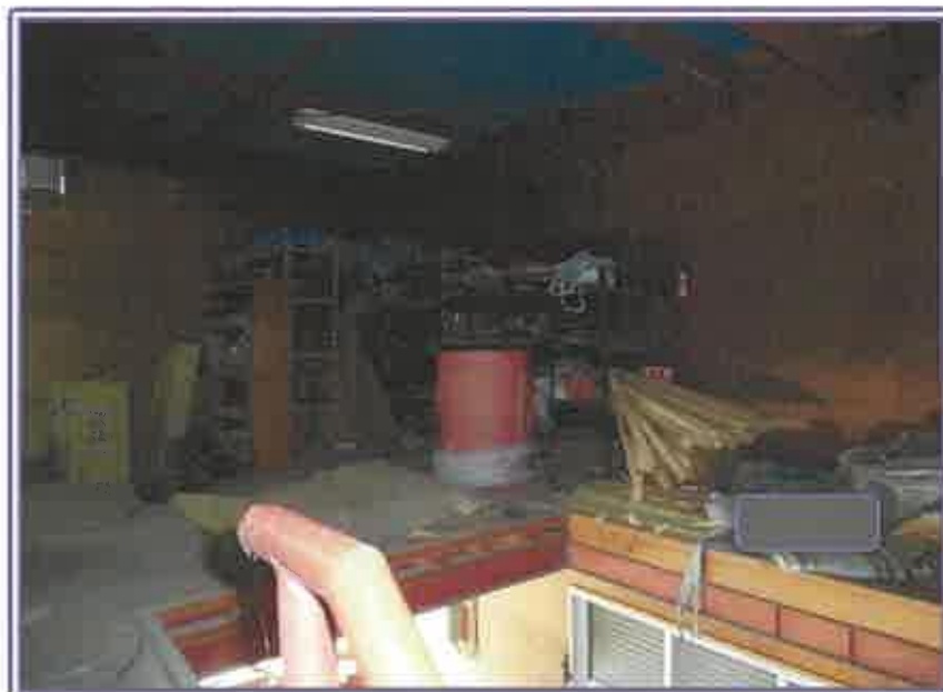
2階 倉庫（物件3・主たる建物）
