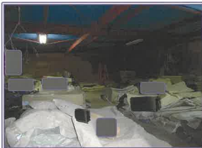
2階 倉庫（物件3・主たる建物）
