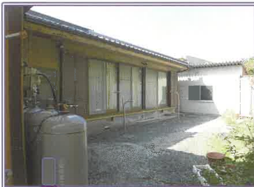
横側 近景 ・ 物件2の建物（居宅）と右端の 物件3・附属建物1（物置）
