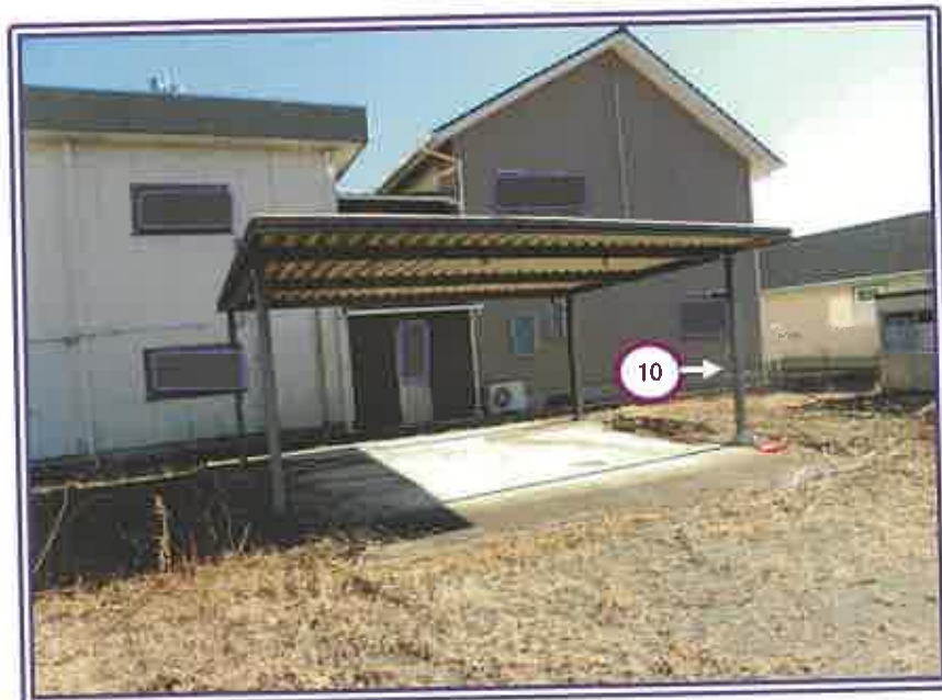
敷地内のカーポート（カーポートの背後は 敷地（912）上の建物）
