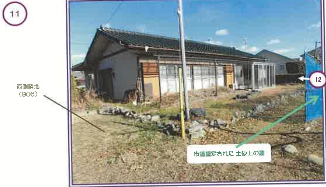
物件4の居宅の西側全景
