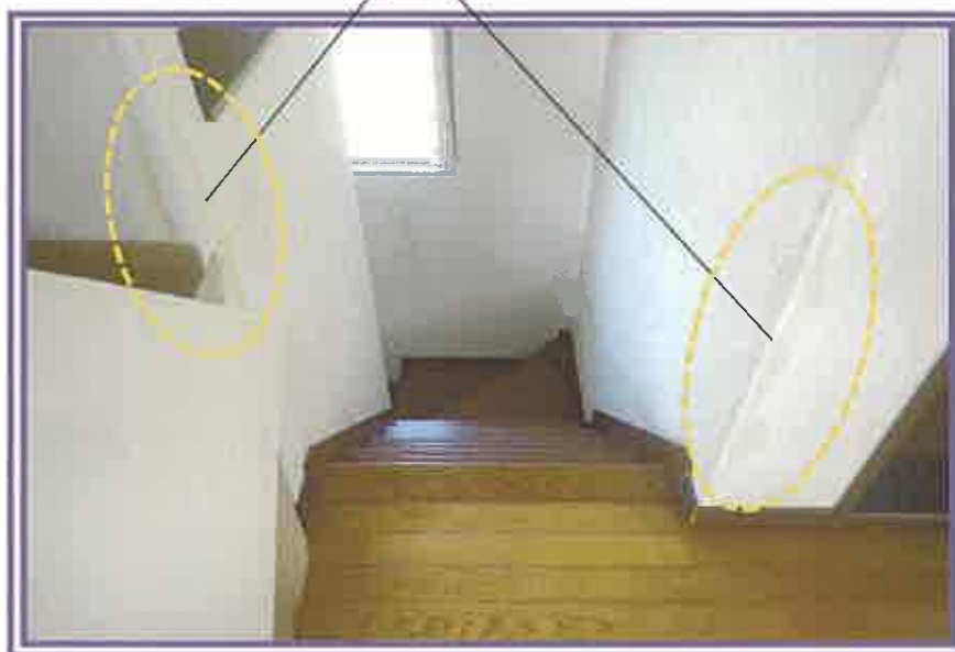
2階から、階段方向を撮影したもの
