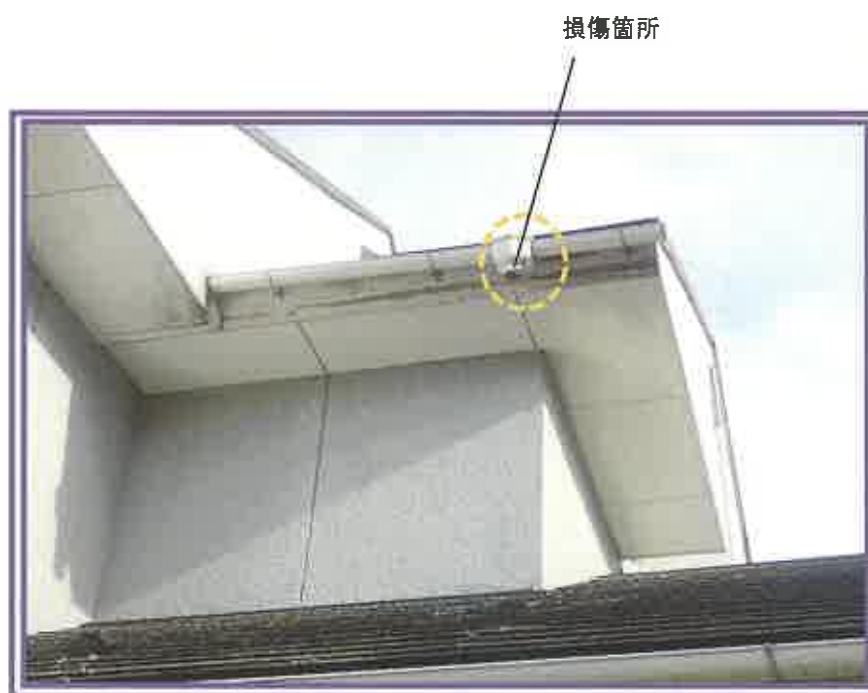
雨樋のうち、集水器より下部が欠落している状況を撮影したもの
