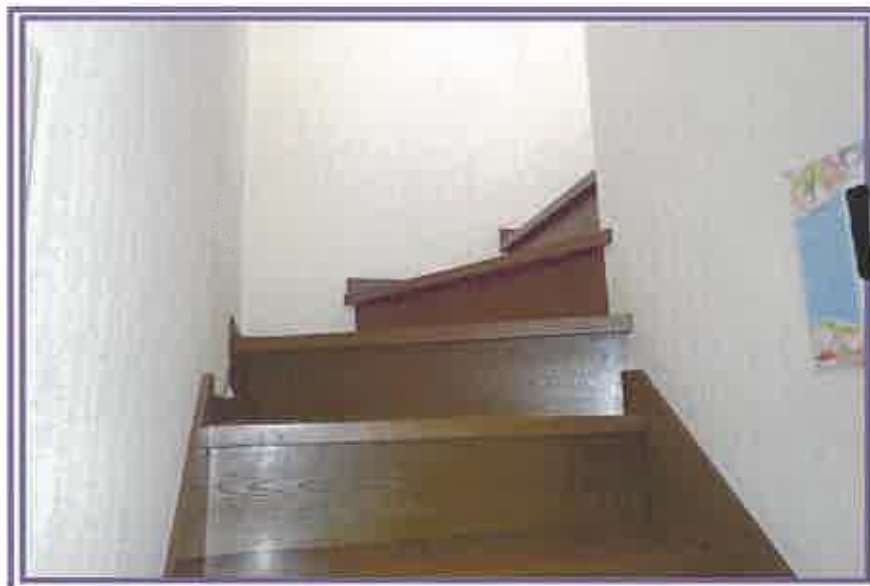
1階から、階段方向を撮影したもの
