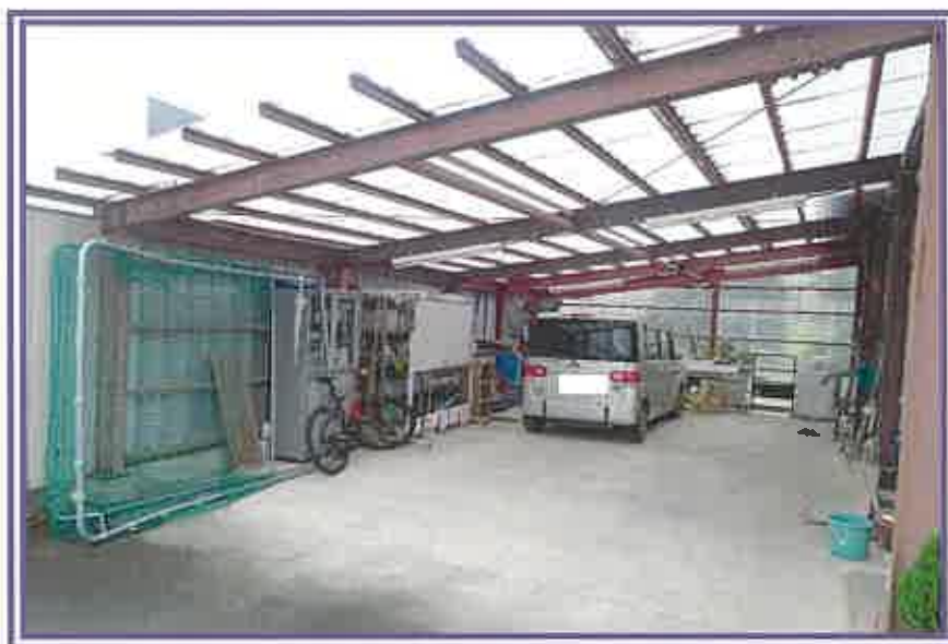
下屋内部を撮影したもの
