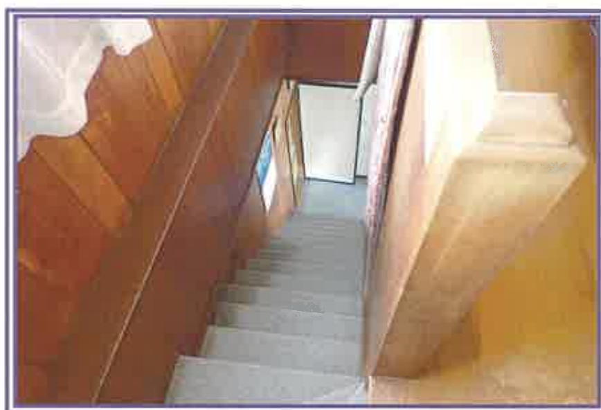
2階から、階段方向を撮影したもの
