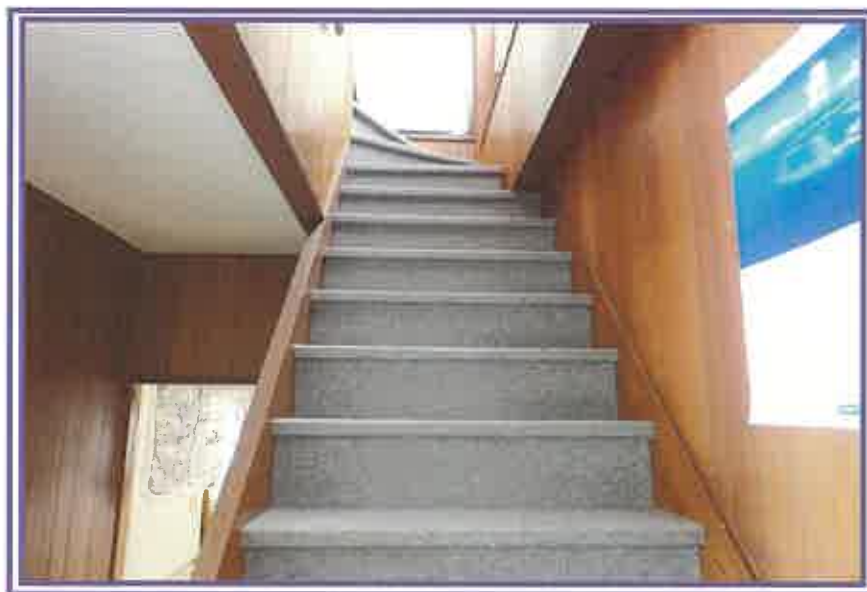
1階から、階段方向を撮影したもの
