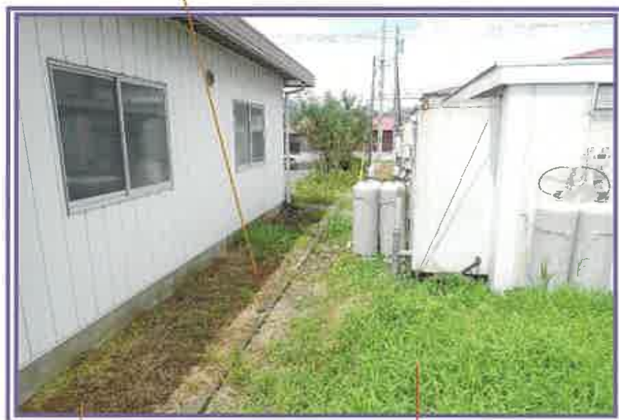
西側隣地 (3236)付近
