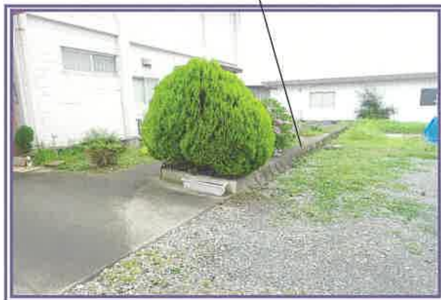
コンクリート製の低い擁壁
