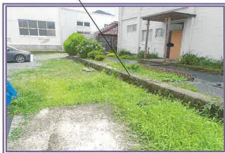
コンクリート製の低い擁壁
