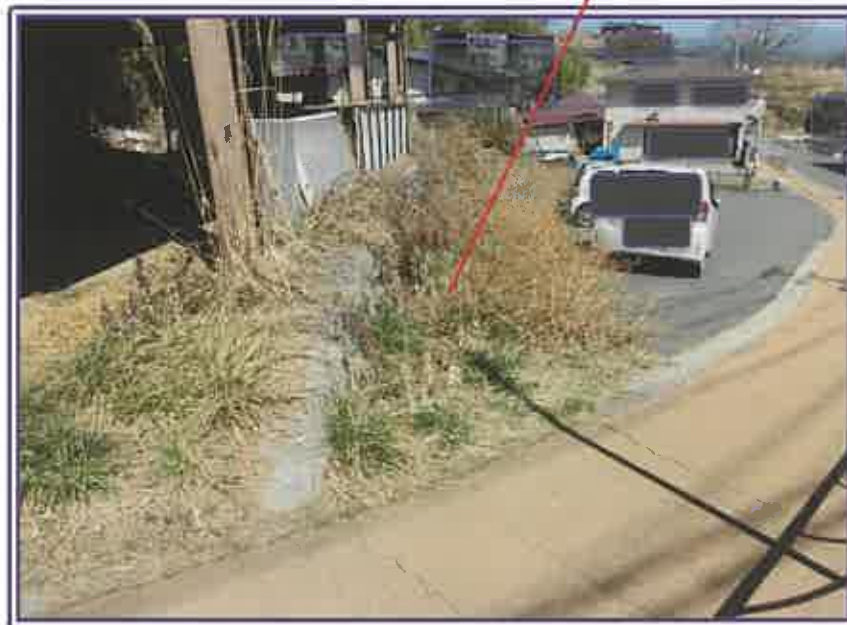
物件12の土地の状況 （おおよそ石垣とアスファルト舗装された駐車場に挟まれた土砂状の幅狭の土地）
