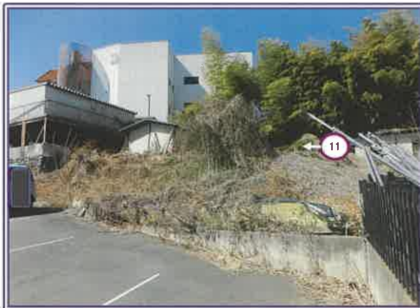
物件13の土地の南側境界付近の状況 （コンクリート土留上の土砂状の土地が本件土地・手前は駐車場である隣地（2468-1））
