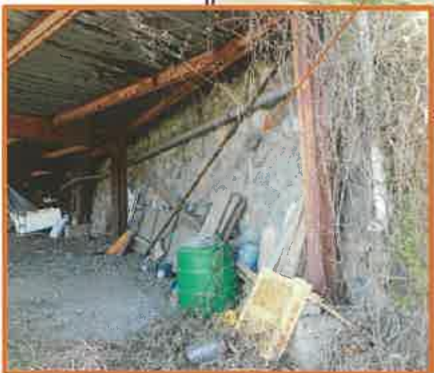
法面状の石垣 （高さ約3m）
