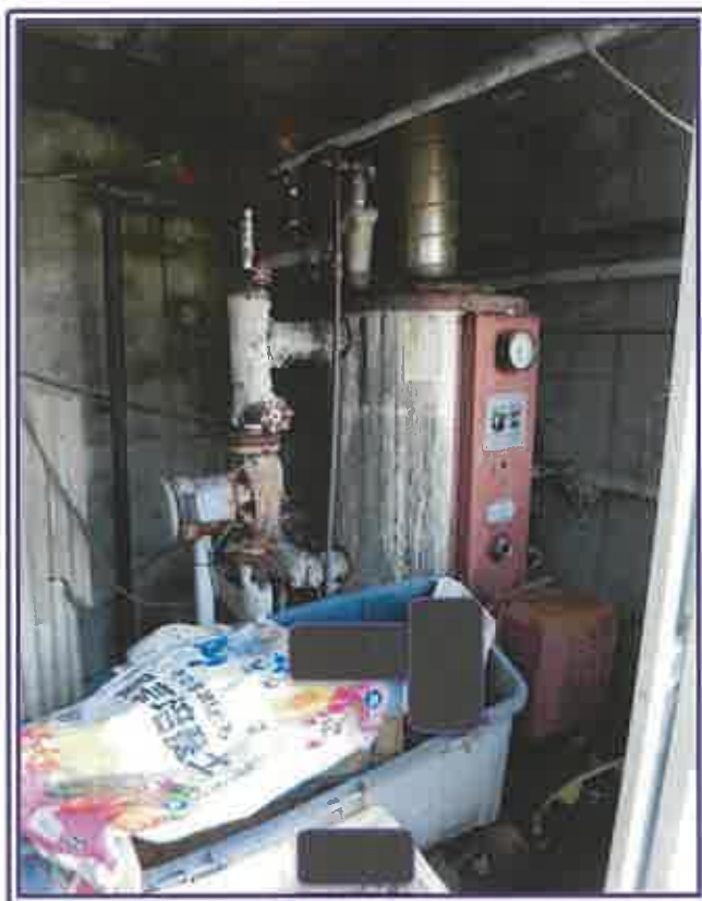
1階 ボイラー室
