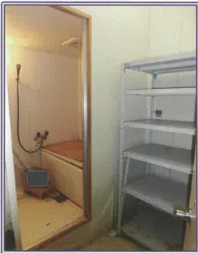
1階 脱衣室（手前）・浴室（奥）
