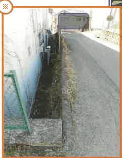
本件建物の底地（低）の状況 （接面道路（高）との高低差は約3m）
