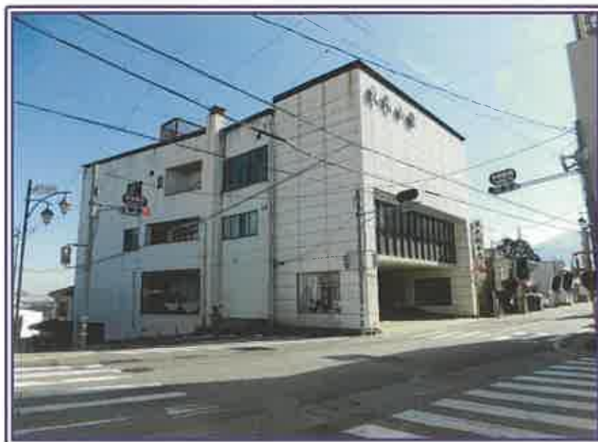
本件建物の北側近景
