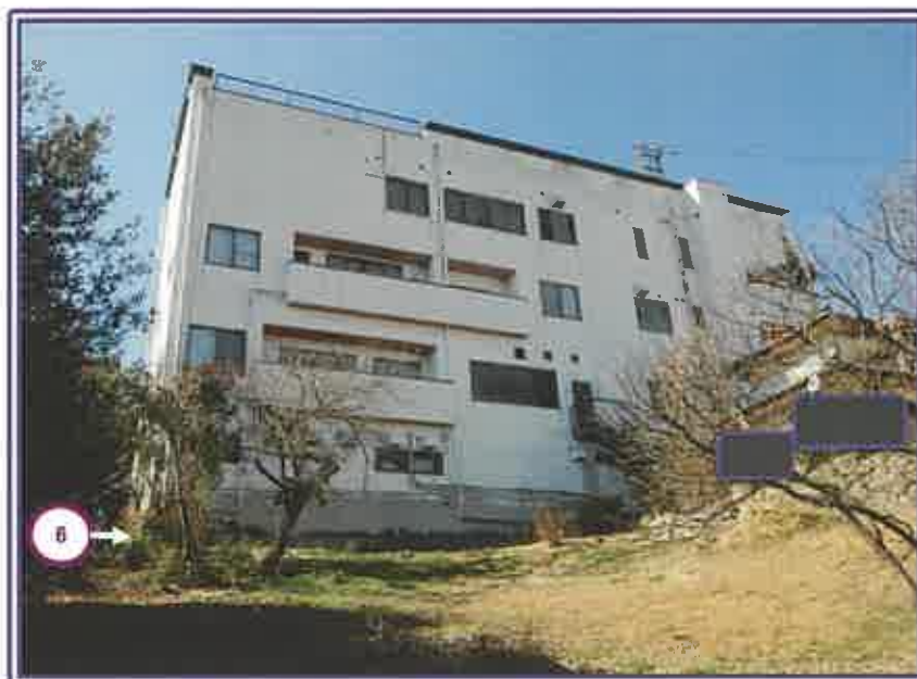
本件建物の裏側近景
