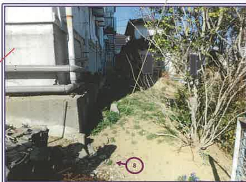
土砂状の抜け道（2575-50）との隣接状況
