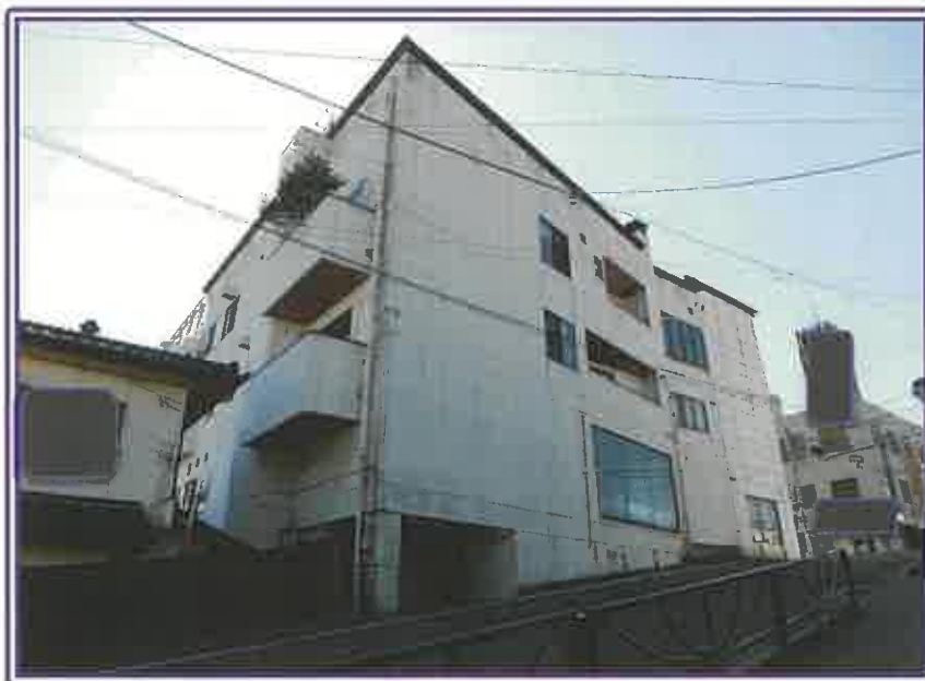
本件建物の東側近景
