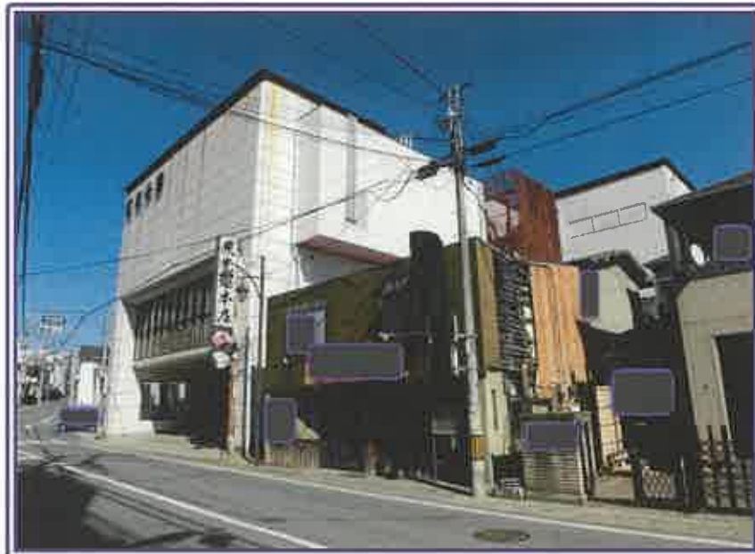
本件建物の西側近景
