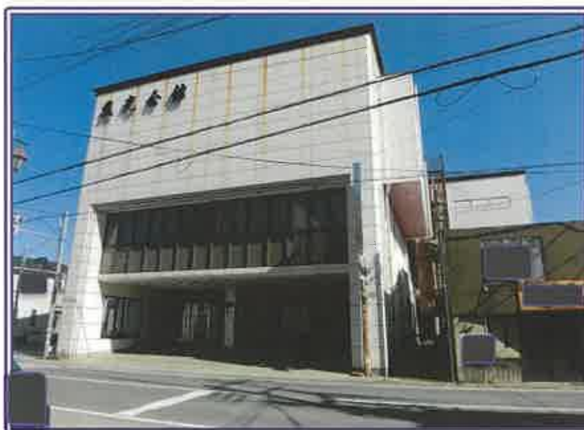
本件建物の正面近景
