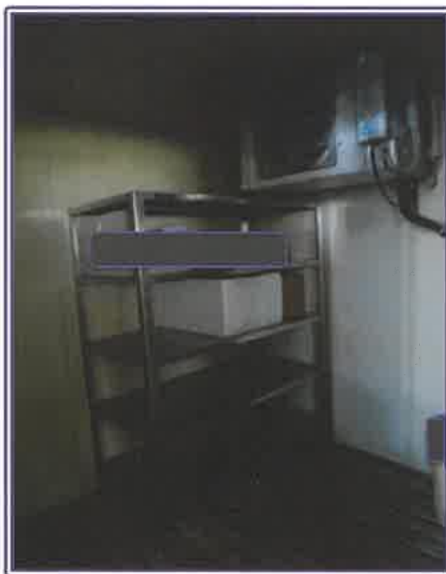
地下1階 冷蔵(凍)庫
