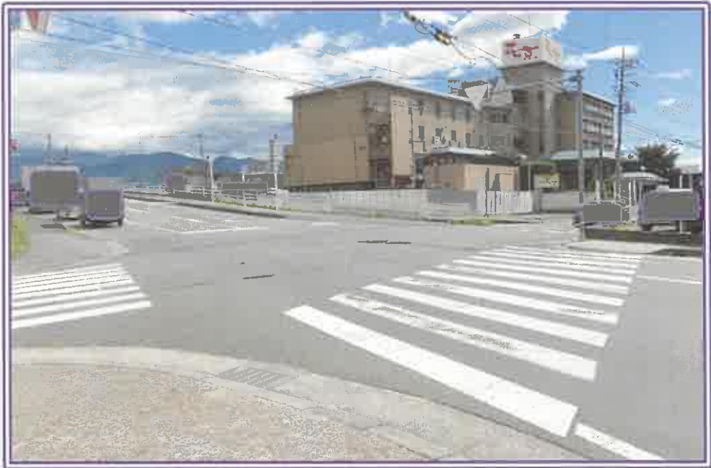
道路状況（手前の県道は 奥の交差点で 国道に通じる）
