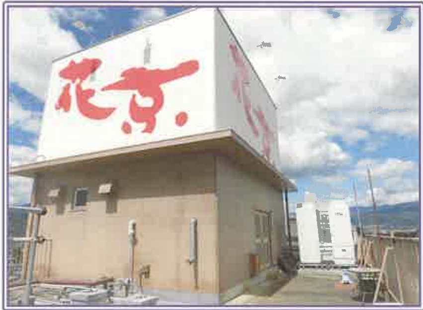
6階 東側機械室・7階 機械室（広告塔の内部）（物件5・主たる建物（旅館））
