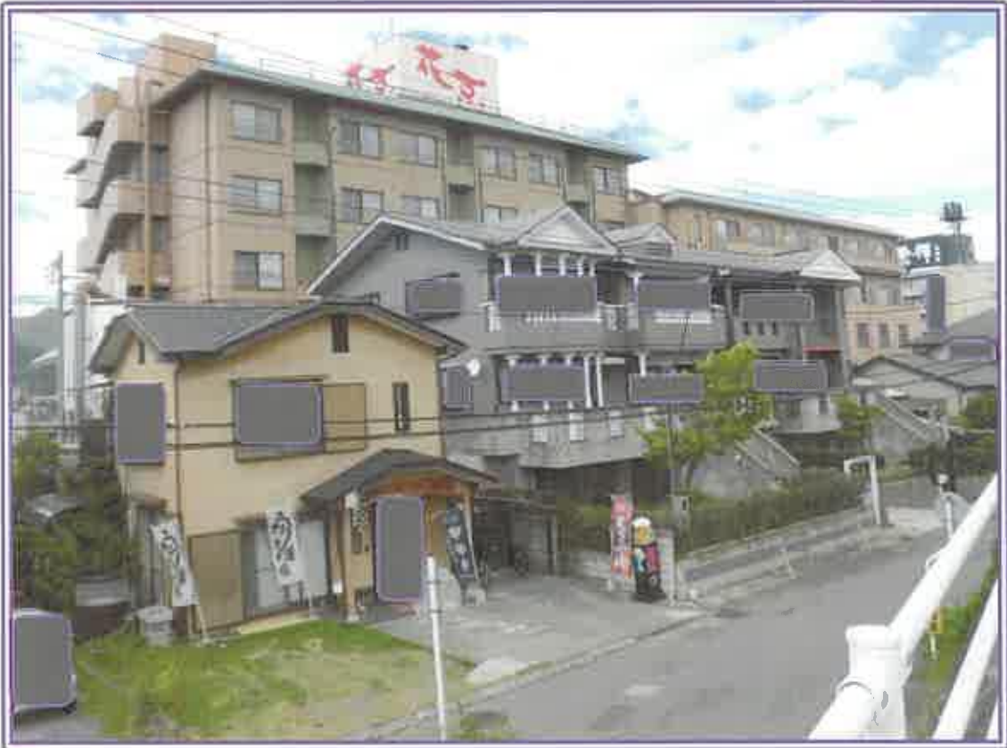
物件5・主たる建物（旅館）の裏側全景（手前の建物は 近隣の宿泊施設・店舗等）
