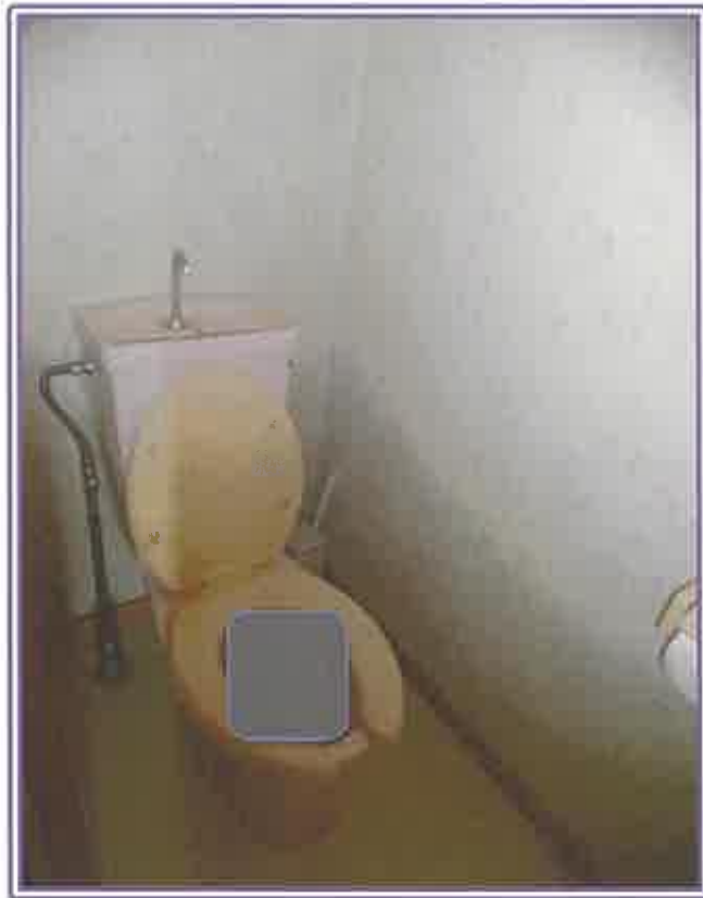
トイレ（物件7建物（寄宿舍・車庫））
