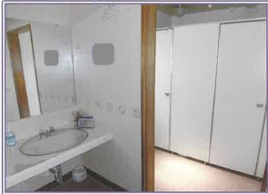
2階 料亭内のトイレ（物件5・主たる建物（旅館））
