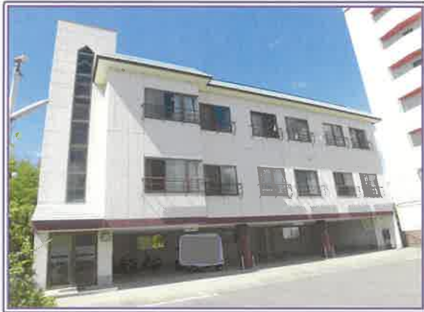
物件7・建物（寄宿舍・車庫）の正面近景
