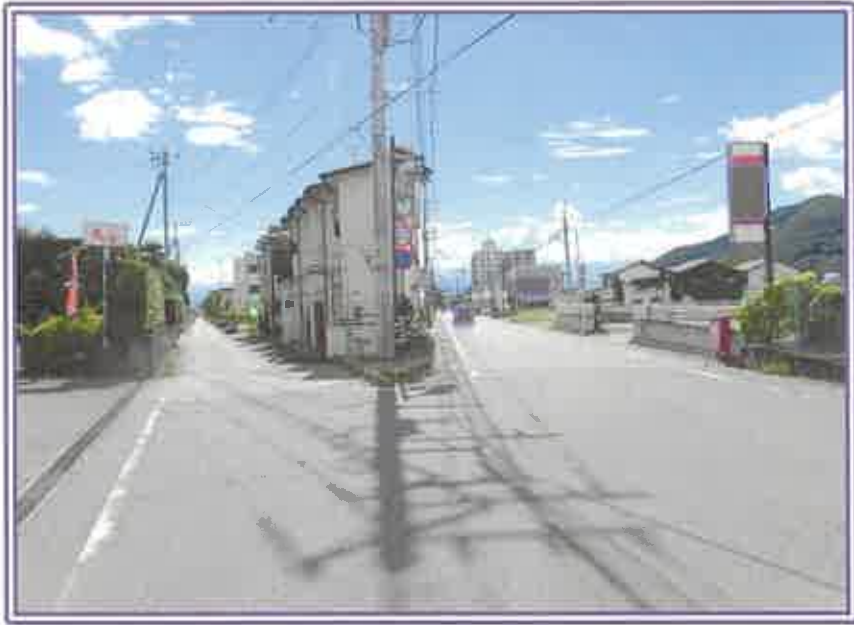
前面市道の状況
