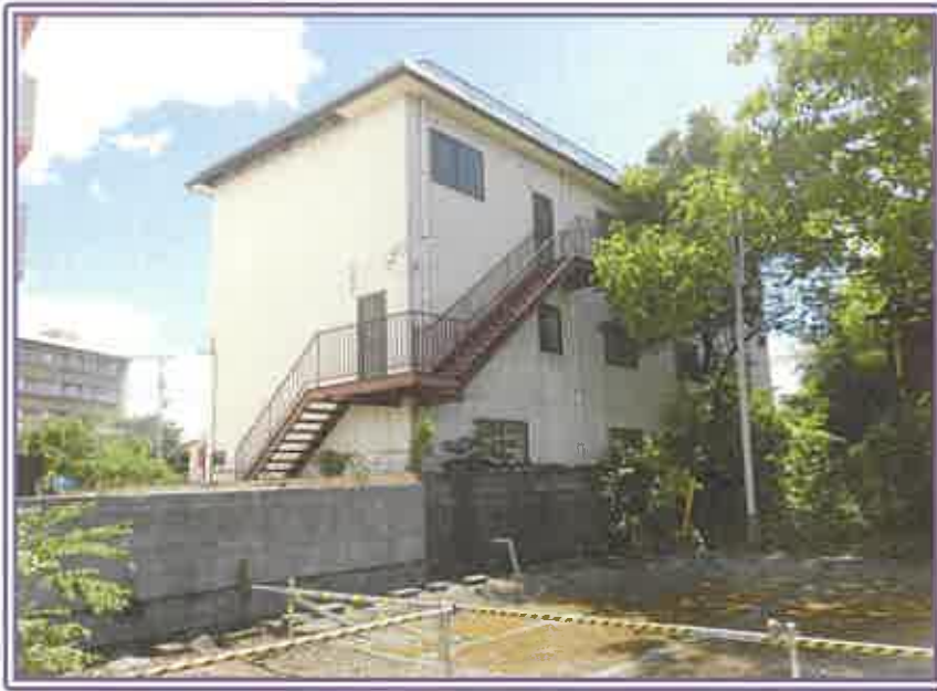
物件7・建物（寄宿舍・車庫）の裏側近景
