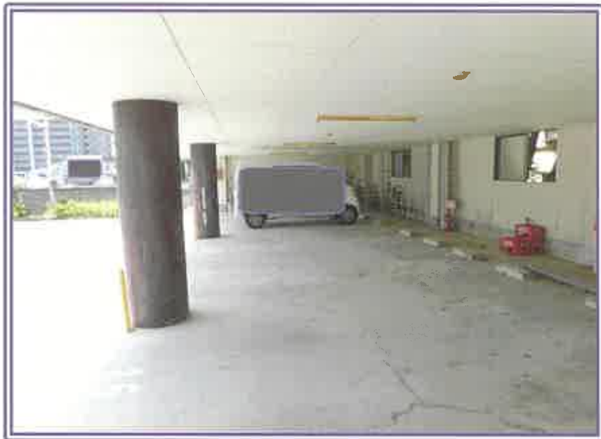
1階車庫（物件7建物（寄宿舍・車庫））
