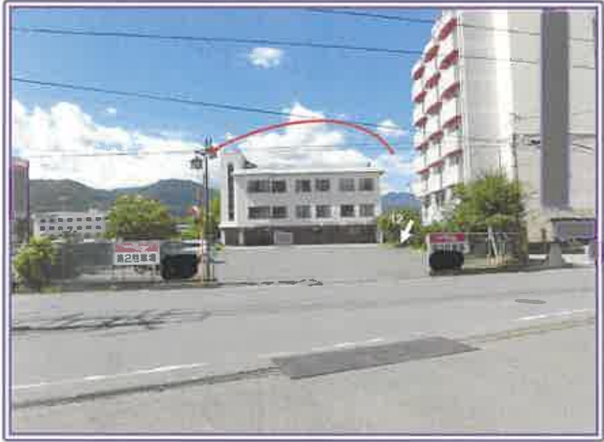
物件ア・建物（寄宿舍・車庫）とその敷地（手前は駐車場）
