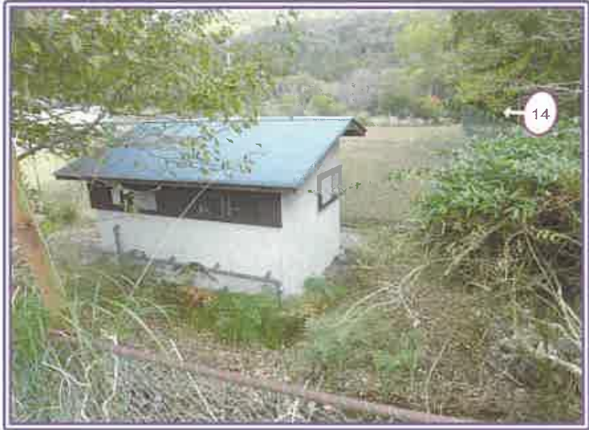
南側で隣接するテニスコート（小屋の奥・1298-1の土地内）の状況 ※ テニスコートの奥に沿って 国道が伸びている
