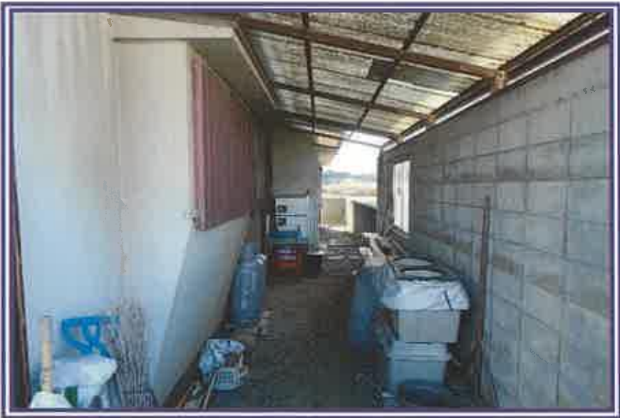
下屋内部を撮影したもの
