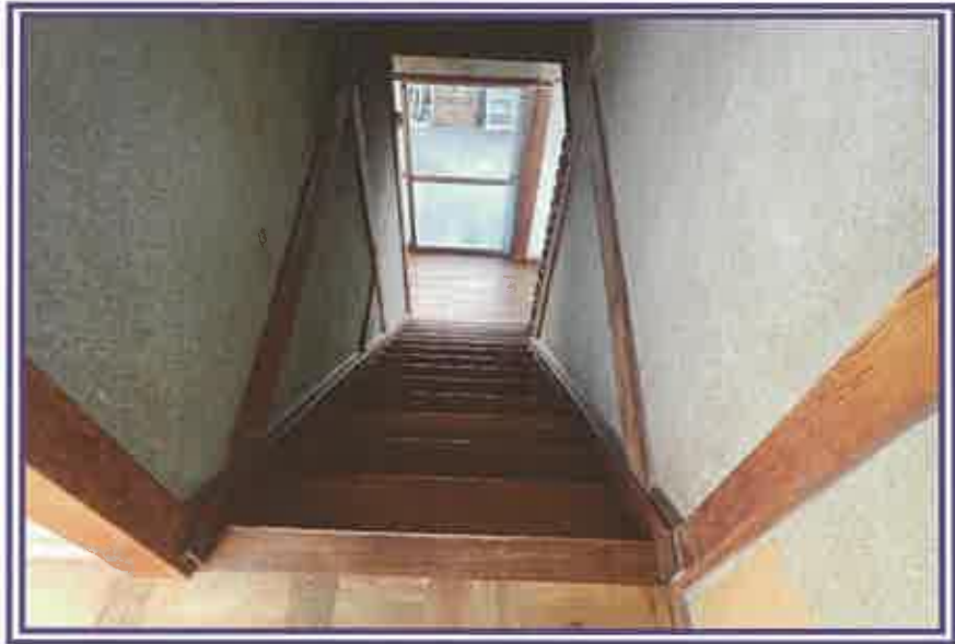
2階から階段方向を撮影したもの
