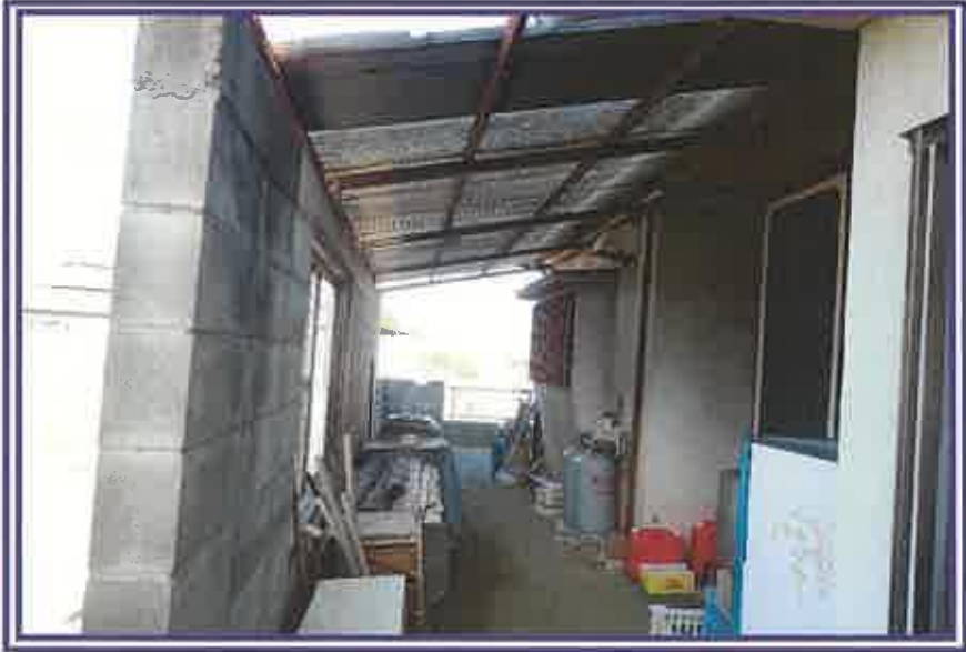
下屋内部を撮影したもの
