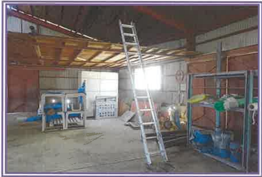
ロフト用の階段付近を撮影したもの
