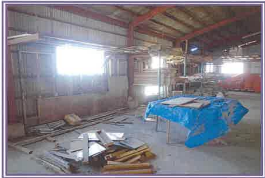
建築資材等が置かれている状況を撮影したもの
