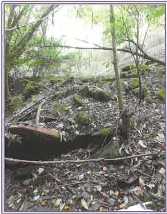
物件8・9の土地間付近の法面（約1mの高低差）の状況
