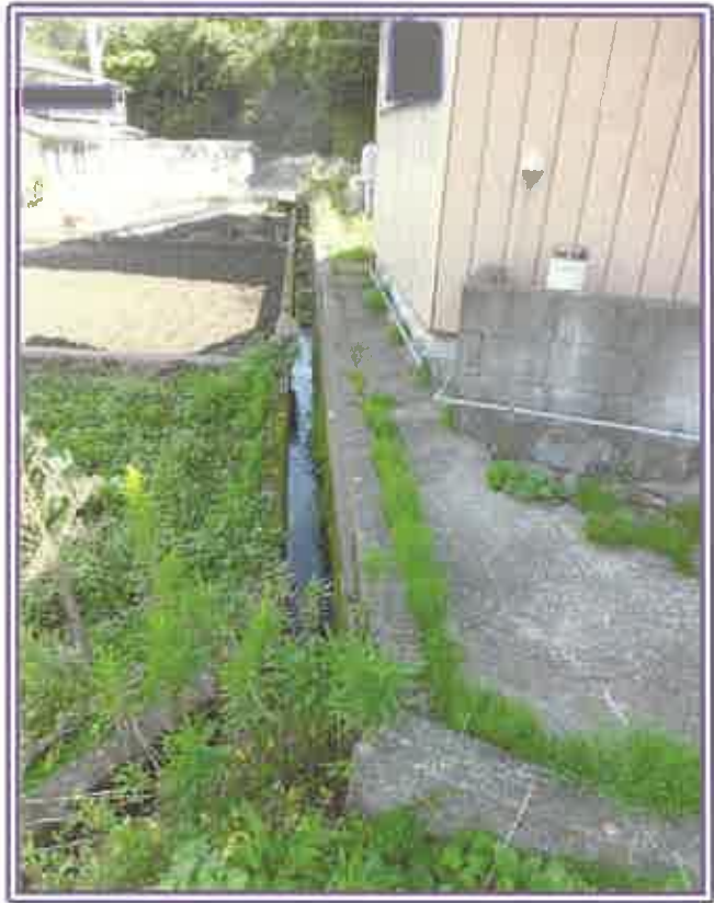
物件3の水路の状況
