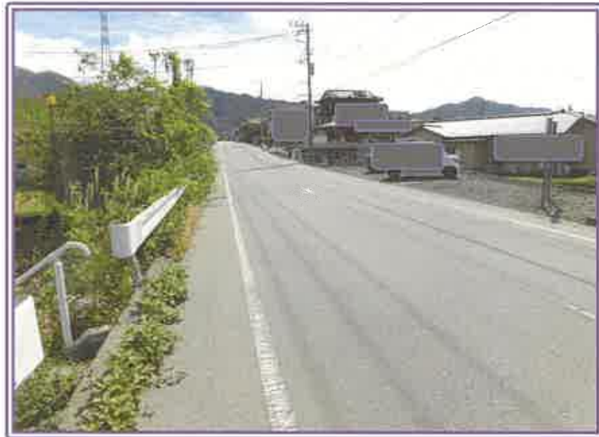
西側本道との接道状況
