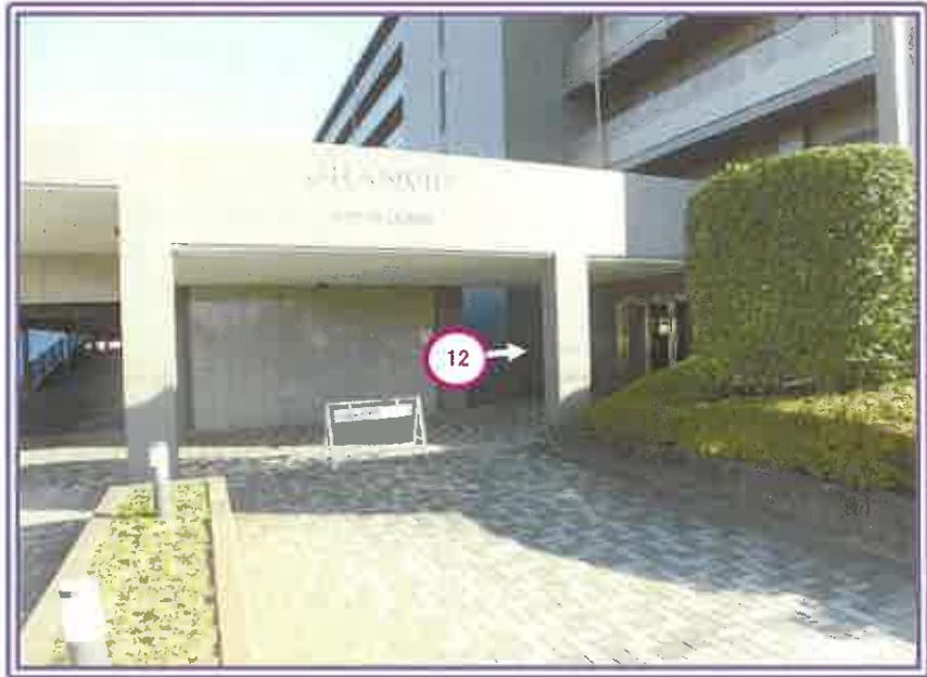
エントランスゲート
