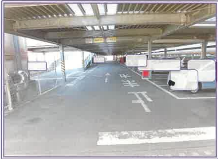
敷地内立体駐車場（1階）
