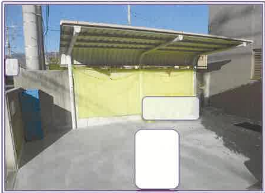
敷地内のゴミ置場
