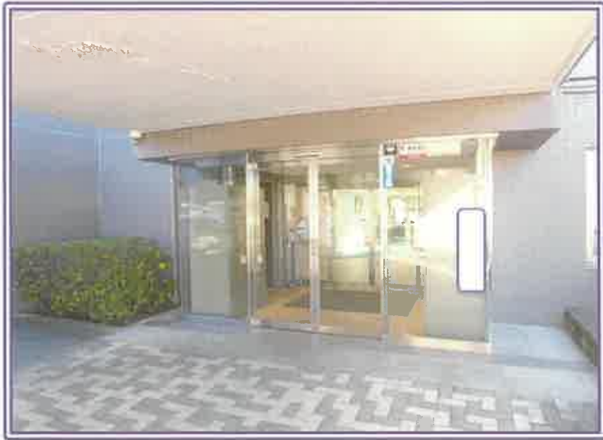
エントランス ポーチ
