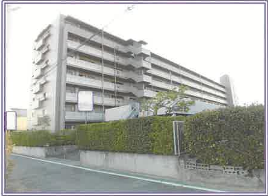
物件1の区分所有建物を含む一棟の建物（グランヴィ南甲府）
