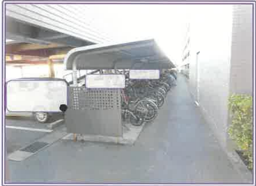
敷地内駐輪場
