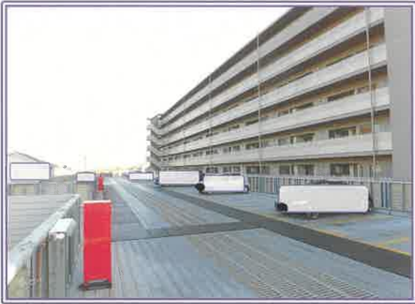
敷地内立体駐車場（2階）
