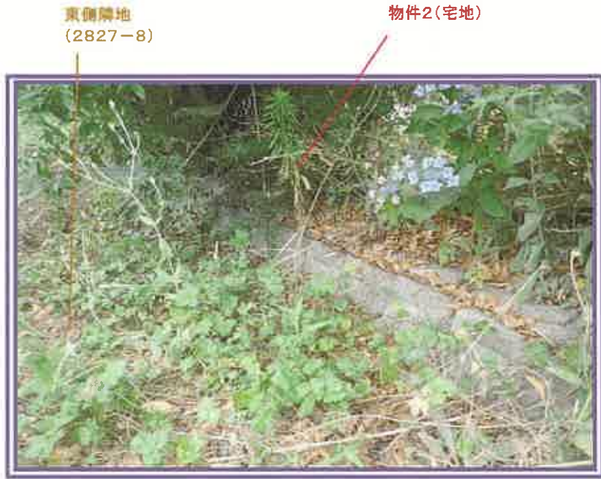
物件2の土地と東側隣地(地番2827番8)との境界付近に、コンクリート製のブロックが積まれている状況を撮影したもの
