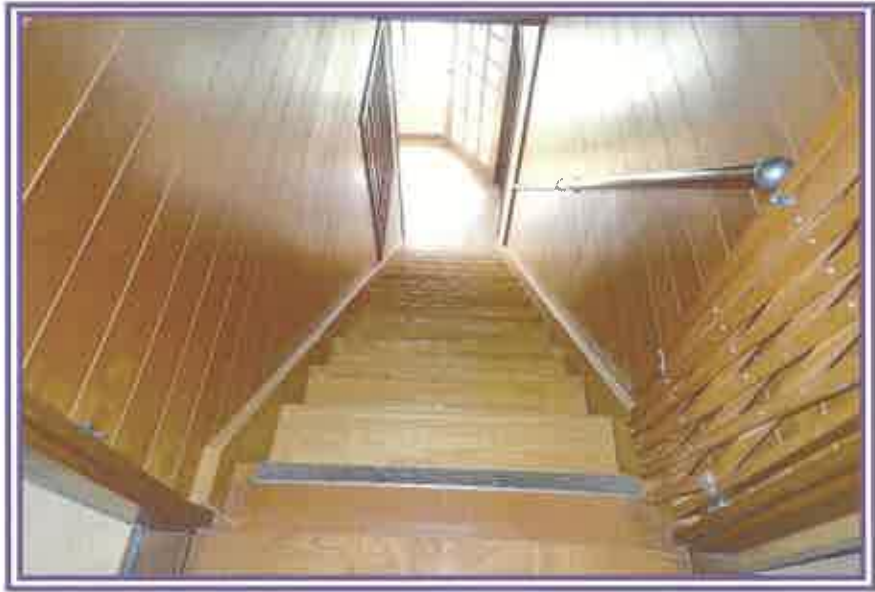
2階から、階段方向を撮影したもの
