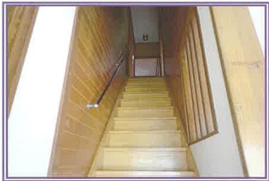
1階から、階段方向を撮影したもの
