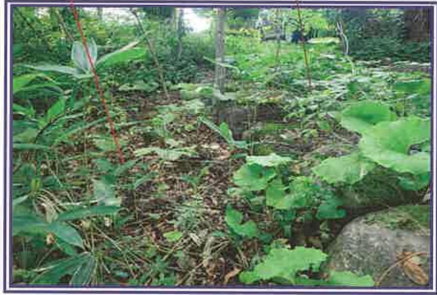
物件5(山林)と北側隣地(地番1176番632)との境界付近に石積みが設置されている状況を撮影したもの
