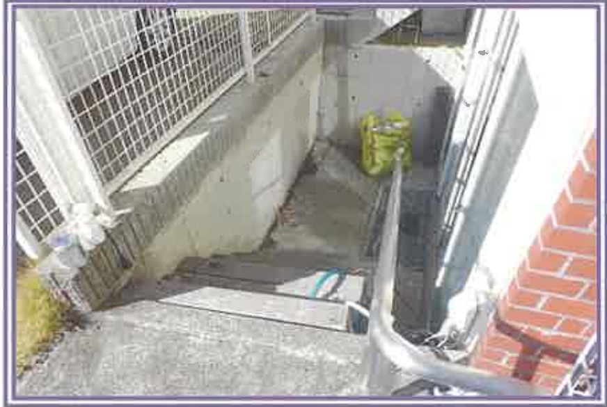
地下1階へと通じる外階段及びその周辺を撮影したもの
