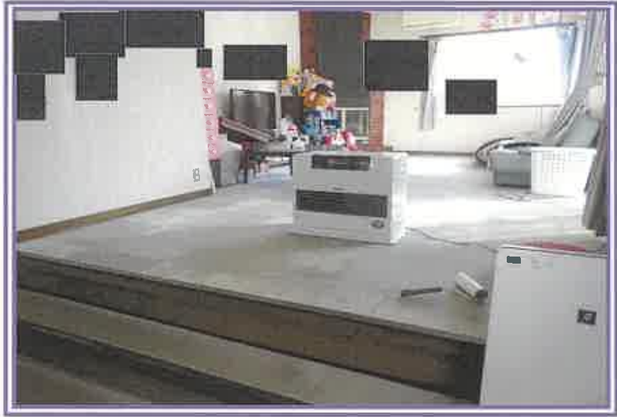
ダイニングからリビング方向を撮影したもの
