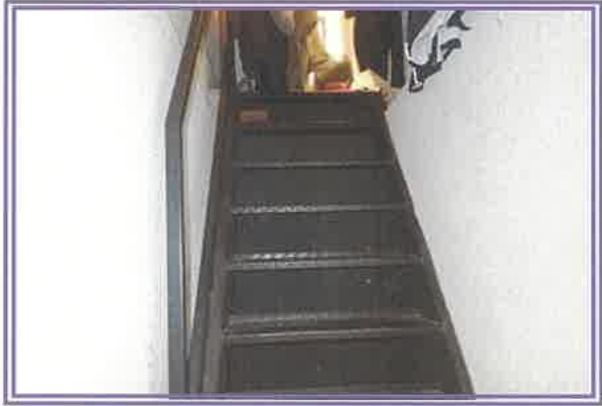
地下1階から、階段方向を撮影したもの
