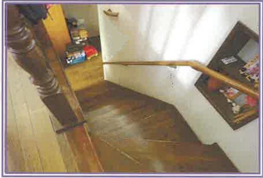
2階から、階段方向を撮影したもの
