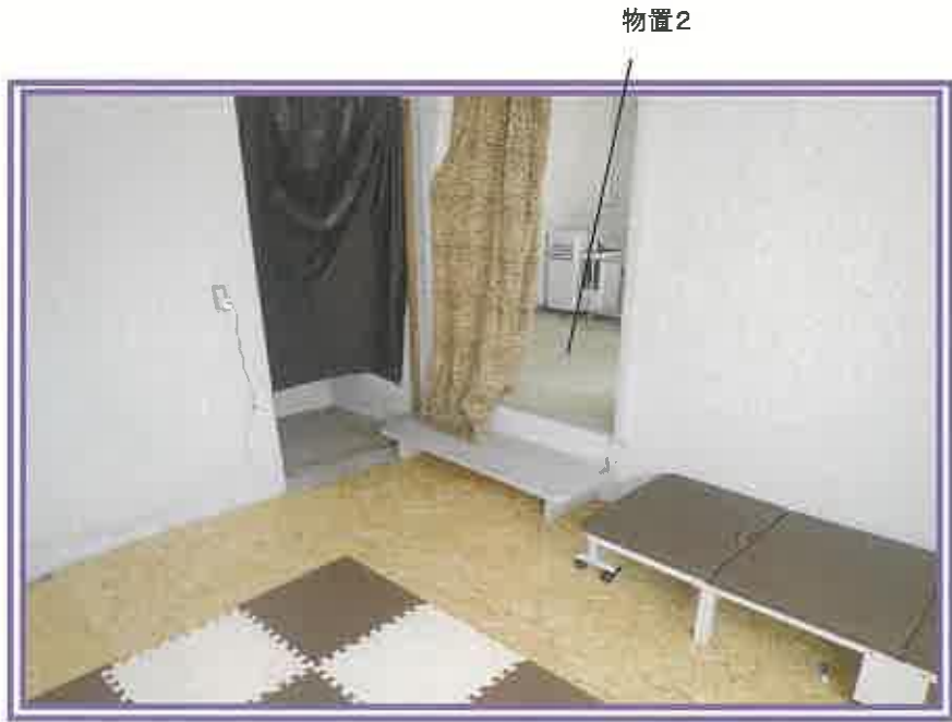
物置1・2間の、段差の分かる箇所を撮影したもの(地下1階)
