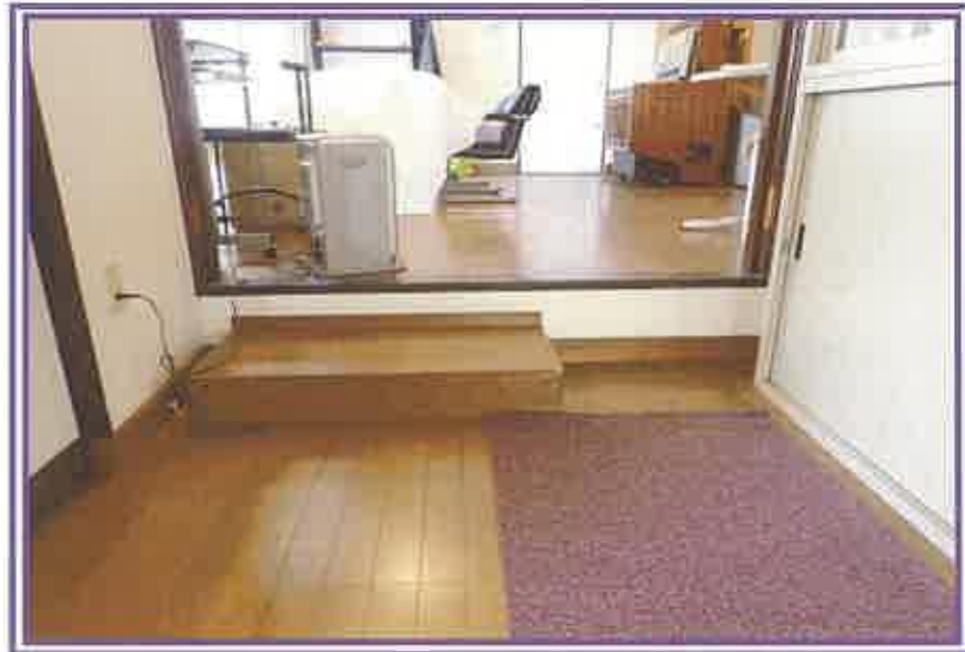
1階廊下(低)と居室(間取図中の「洋室1」)(高)との間に、段差が施されている状況を撮影したもの
