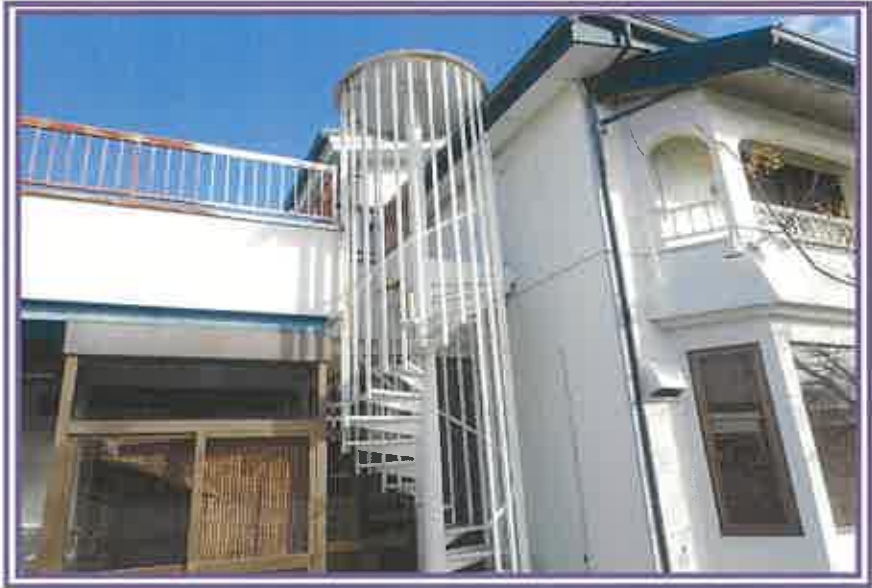
外階段(らせん階段)及びその周辺を撮影したもの
