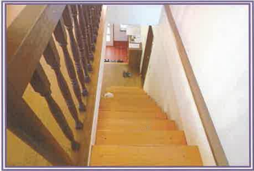
2階から、階段方向を撮影したもの
