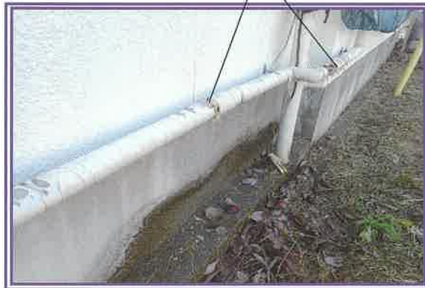
本件建物の水道管から漏水している可能性のある箇所を撮影したもの
