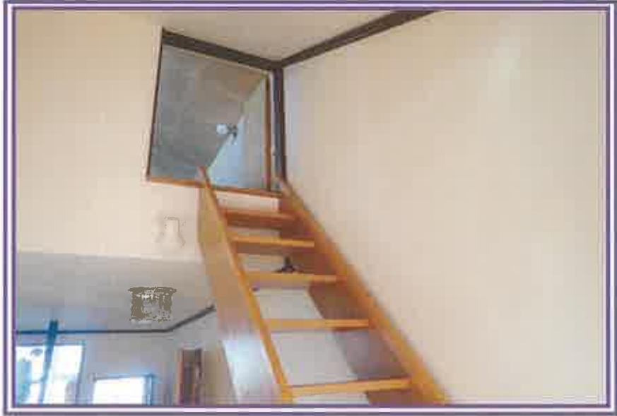
2階から屋根裏入口付近を撮影したもの
