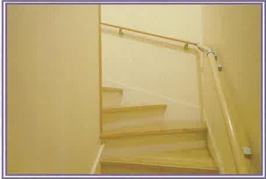
1階から、階段方向を撮影したもの
