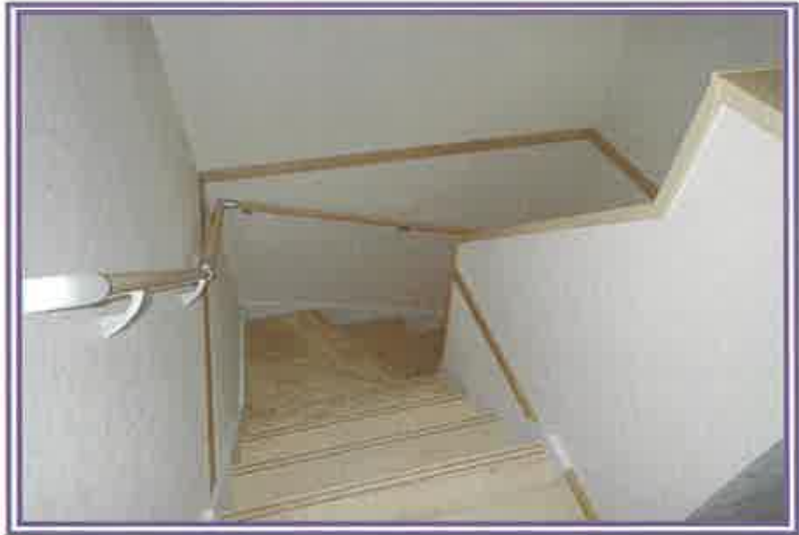
2階から、階段方向を撮影したもの
