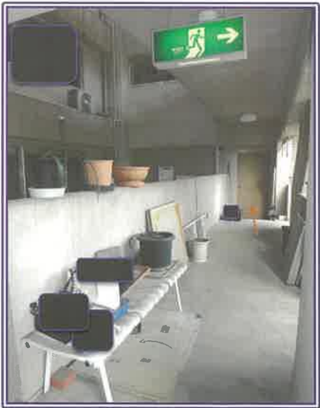
教室（306号室・物件1の区分所有建物）への出入口（眞口）付近
