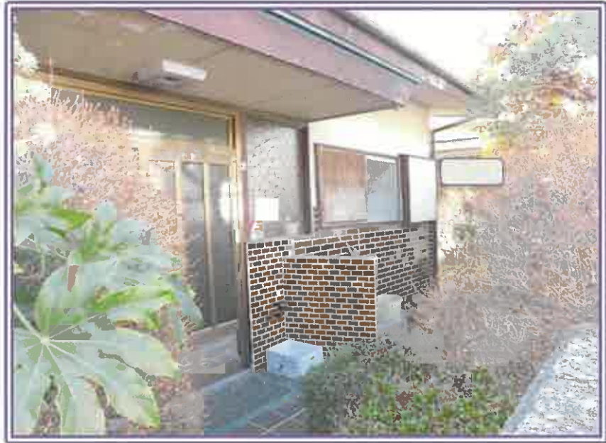
敷地内の状況（玄関前）
