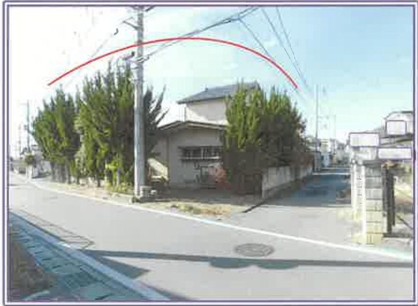
道路側全景（手前は公道・建物の右脇の通路は奥で行き止まる）
