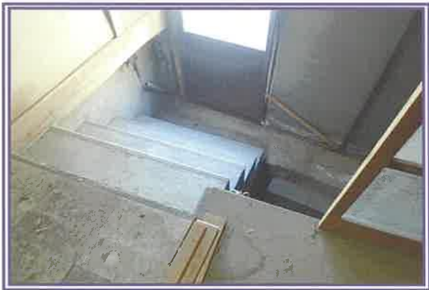
北側階段付近
