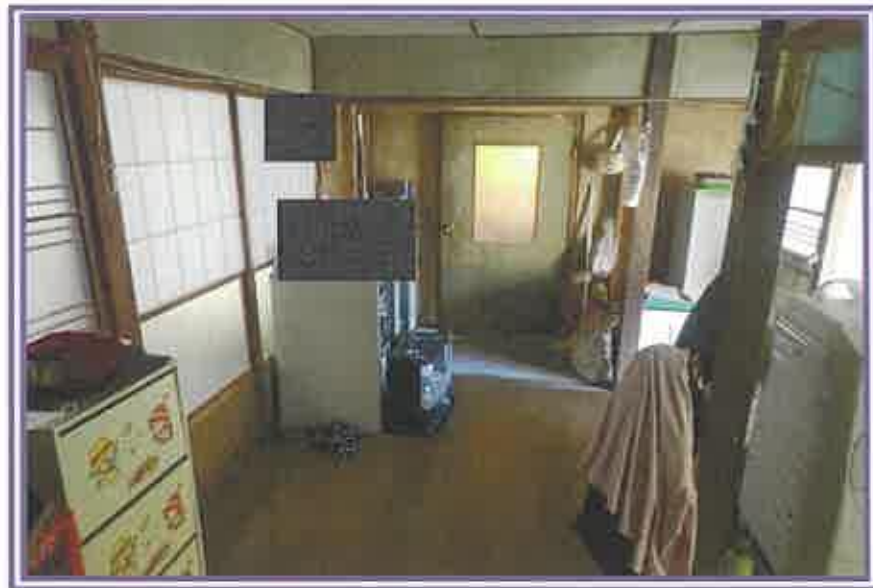
台所付近の廊下
