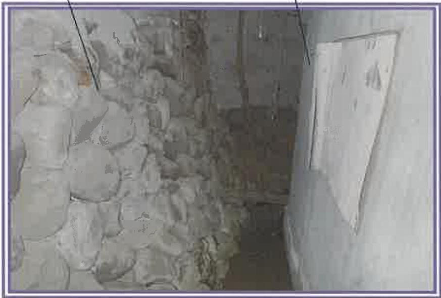
本件建物の外壁と、道路下の石垣等で囲まれている箇所を撮影したもの
