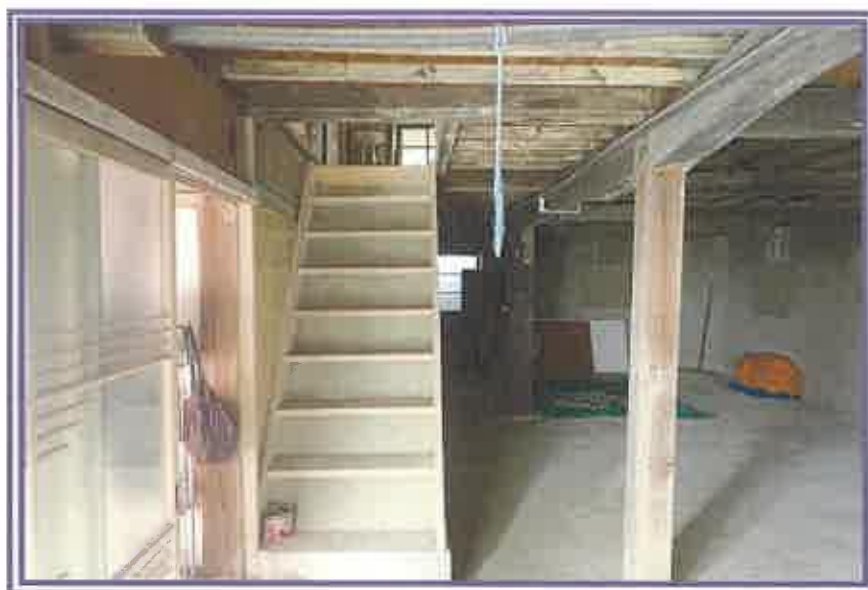
階段(東側)付近
