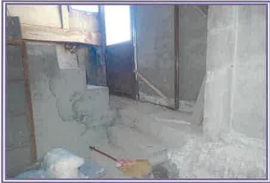
北側階段付近
