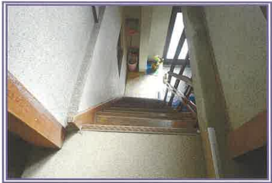
2階から、西側階段方向を撮影したもの
