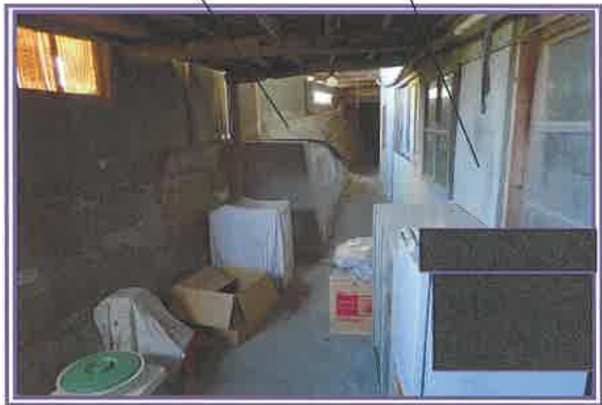
本件建物の外壁
