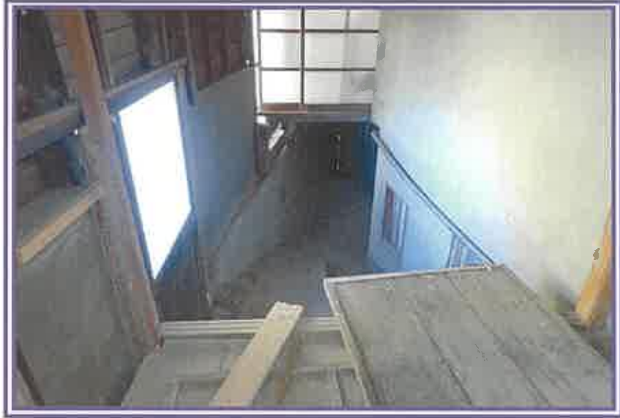
北側廊下(2階)から「吹抜」方向を撮影したもの
