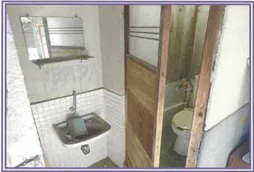
手洗い場所及びトイレ(屋上)
