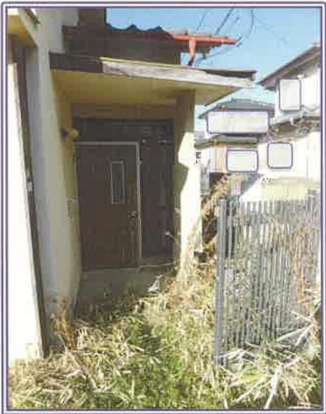
玄関前の状況
