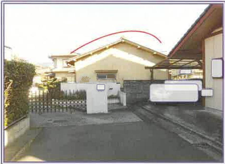
裏道側の状況（建物の手前は 隣宅の門構（464-7・465-16の土地内））
