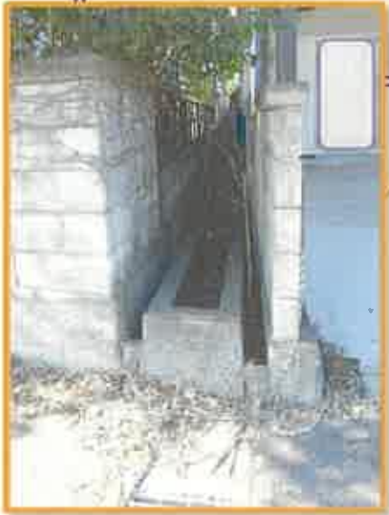
水路との接面状況
