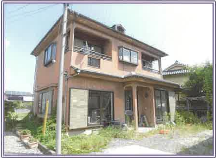
本件建物の正面近景
