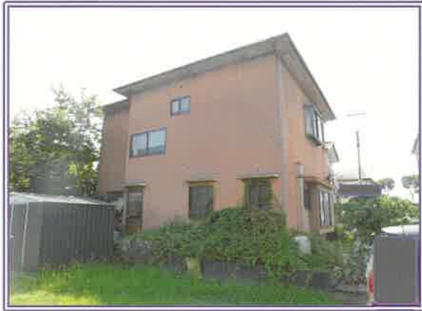
本件建物の裏側近景
