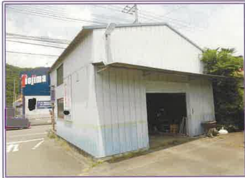
物件5・附属建物（車庫・物置）の近景
