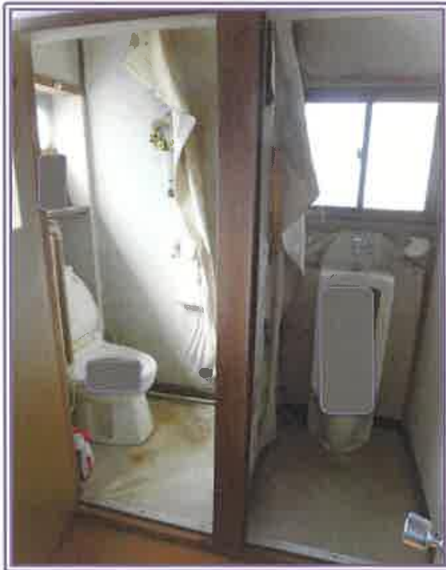
1階 トイレ（物件5・主たる建物）
