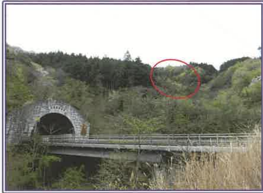
※ 国道52号線（富士川街道）の架橋と身延トンネルの出入口
