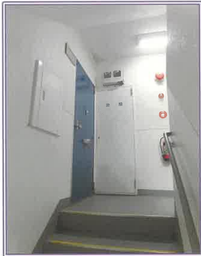
本件区分所有建物（E-237号室）の出入口扉前の現況
