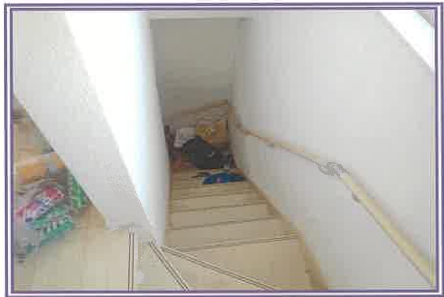
2階から、階段方向を撮影したもの
