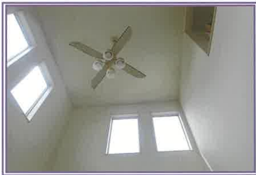
リビングから、吹抜方向を撮影したもの
