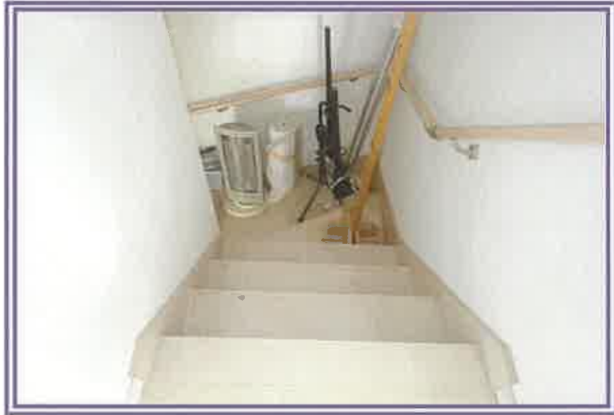
屋根裏付近から、2階へ向かう階段方向を撮影したもの
