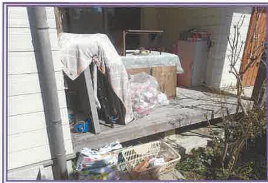
ウッドデッキ及びその周辺を撮影したもの
