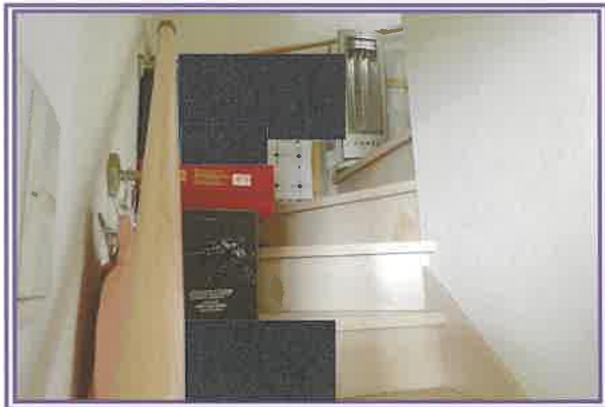
2階から、屋根裏へ向かう階段方向を撮影したもの
