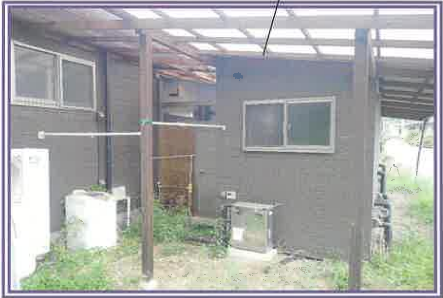
未登記附属建物1(浴室)
