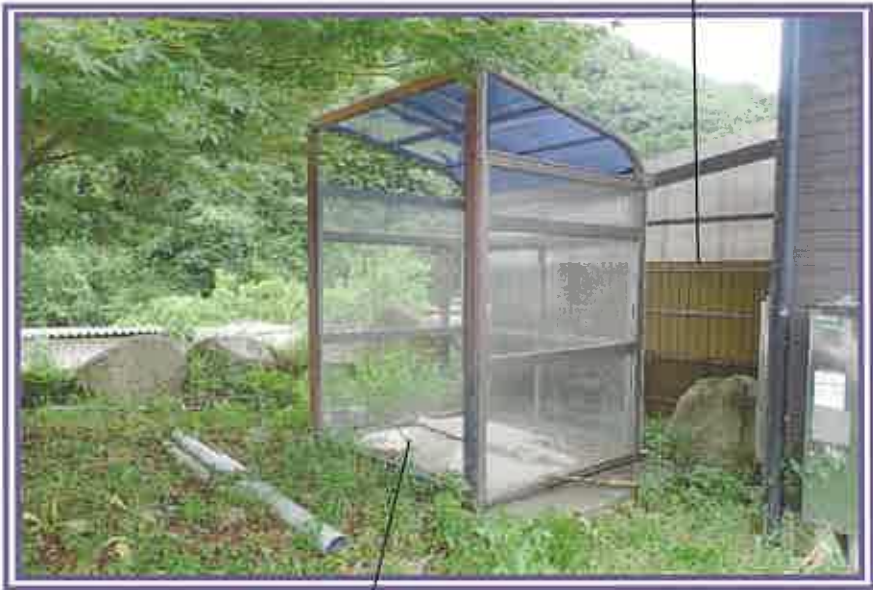
鉄骨造ポリカーボネート葺の 附風構築物2
