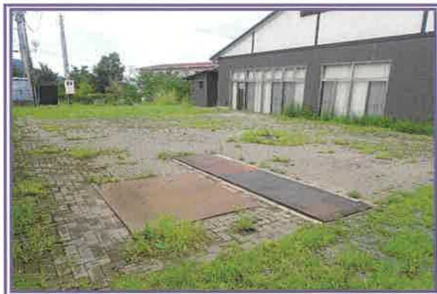
インターロッキング及びその周辺を撮影したもの
