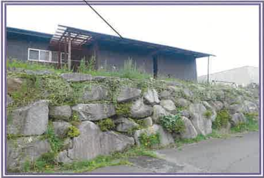
未登記附属建物1, 2(浴室)
