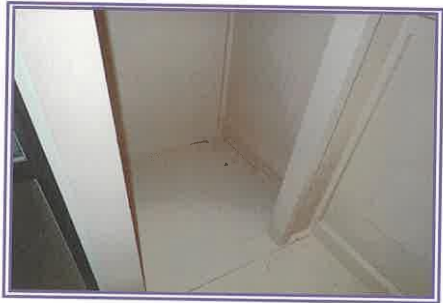
本件建物1階北西角の状況を撮影したもの
