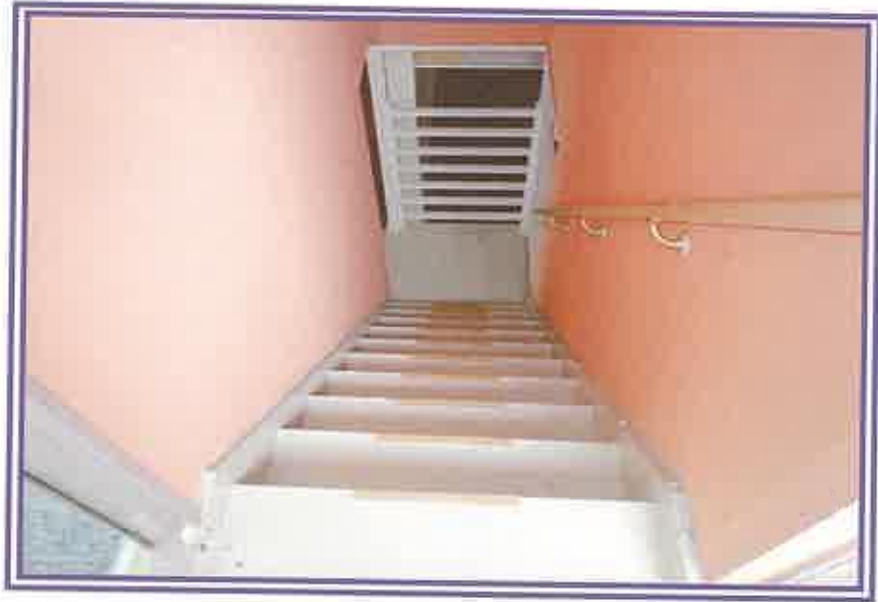
2階から、階段方向を撮影したもの
