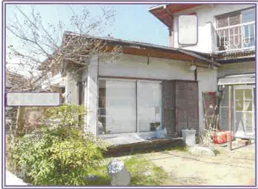
本件居宅の正面近景（平家建部分）
