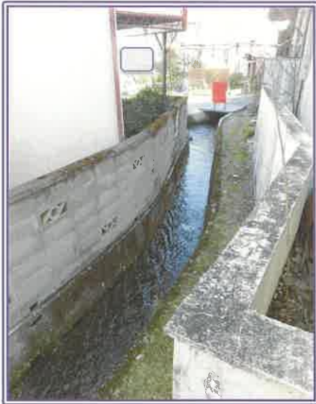
水路（樋のアカミチ）との接面状況
