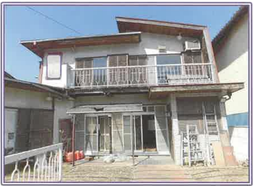
本件居宅の正面近景（2階建部分）
