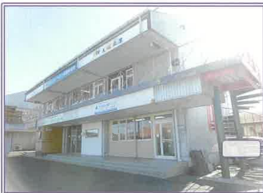
物件9の店舗・事務所の表側近景
