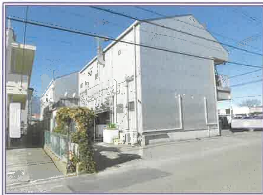
物件8の店舗（手前）の裏側近景
