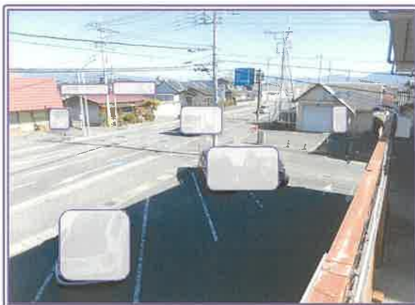
東端側敷地（主に駐車場）内の状況
