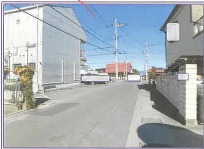
側道との掃道状況
