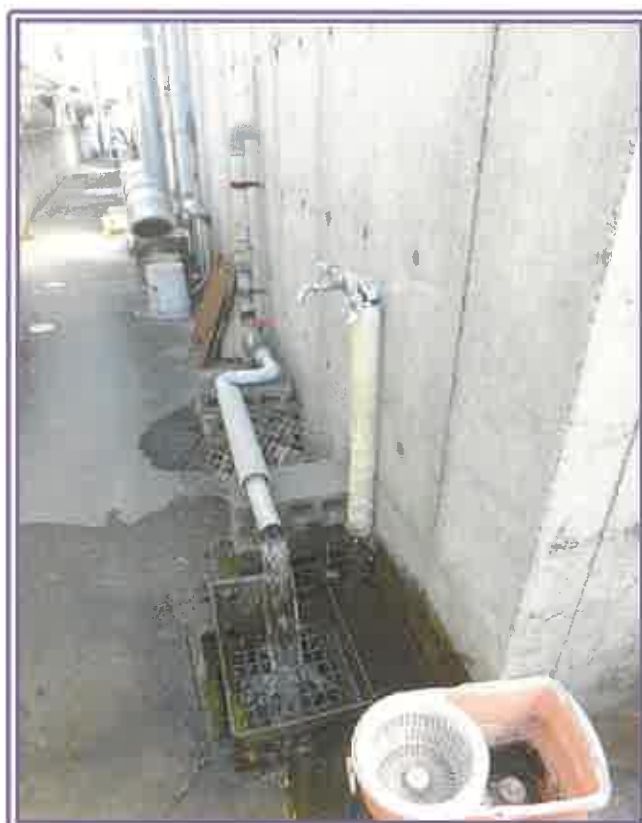
裏側敷地内の湧水管
