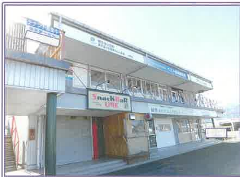
物件9の店舗・事務所の表側近景
