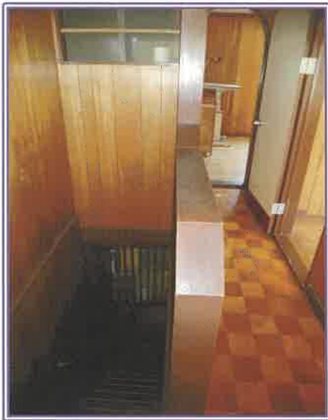
3階階段ホール(居宅内)
