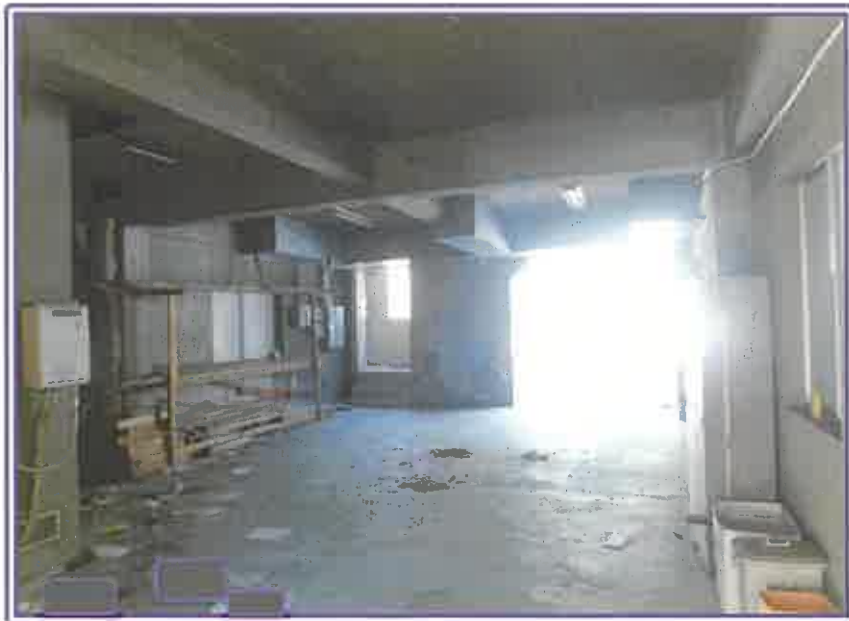
駐車スペース（写真5中の高床式建物の床下部分）
