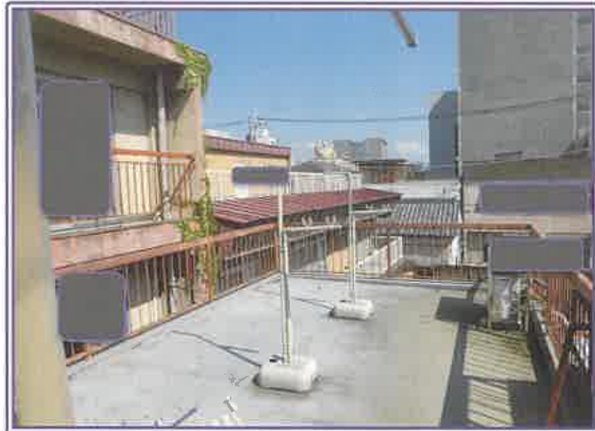
物件4の区分所有建物（居宅・作業所）の3階屋上バルコニー
