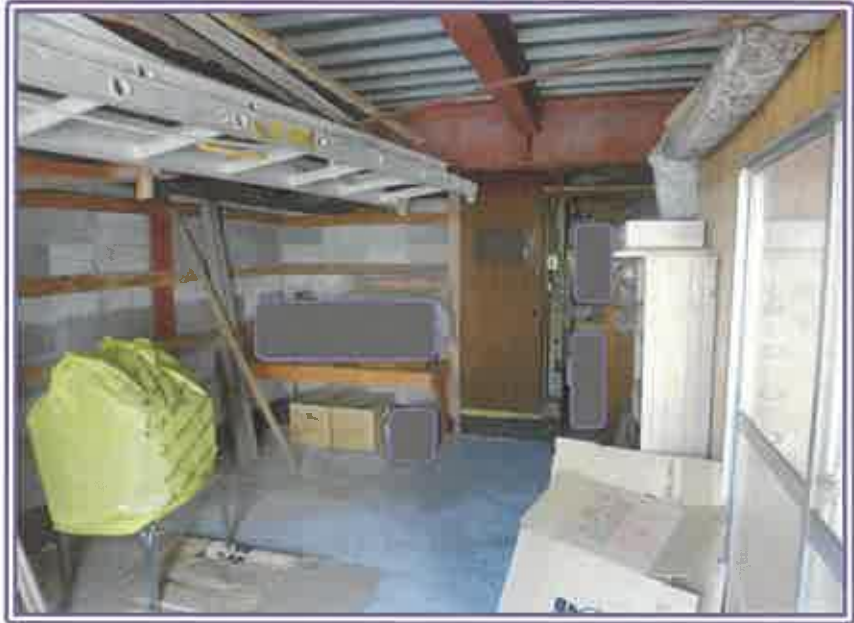
1階 作業室（作業所内）
