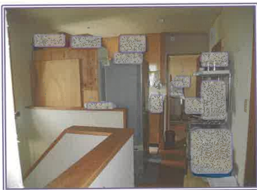
2階 階段ホール
