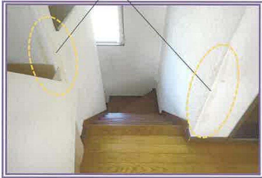
2階から、階段方向を撮影したもの
