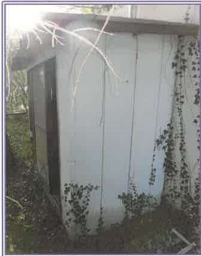
物件4・未登記附属建物2（ポンプ室）
