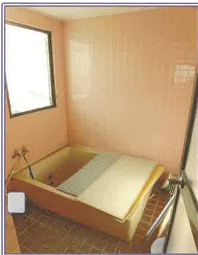
1階 浴室（物件3の居宅）
