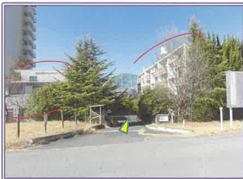
売却対象の 2 棟の共同住宅と 1 棟の居宅 ※ 表側出入口
