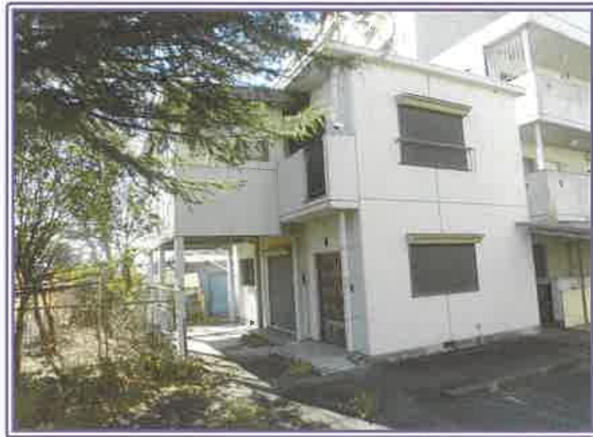
共同住宅の傍らに建築された 物件3の居宅
