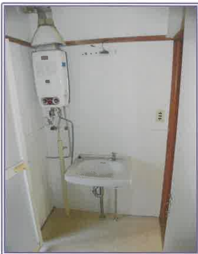
脱衣・洗面室（物件4の共同住宅内の居室）
