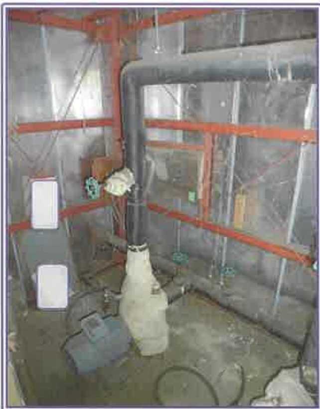
ポンプ室（物件4・未登記附属建物2）
