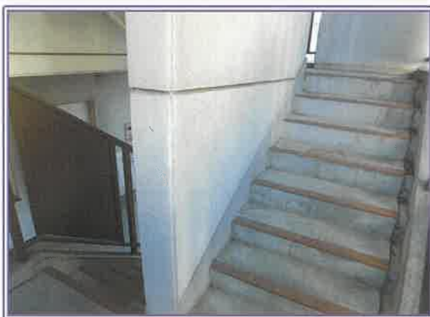
階段（物件2の共同住宅）
