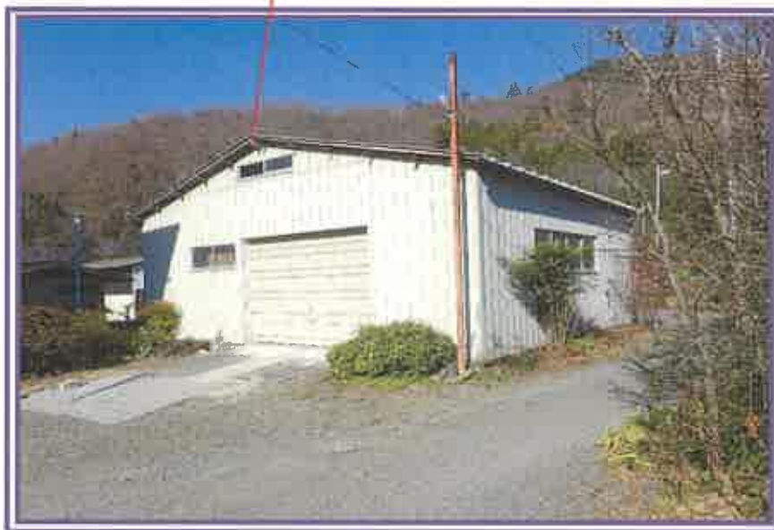
物件13附属建物 符号4(倉庫)
