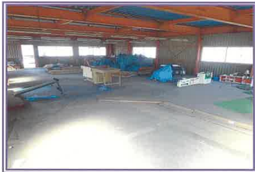
2階倉庫 (物件13(工場))
