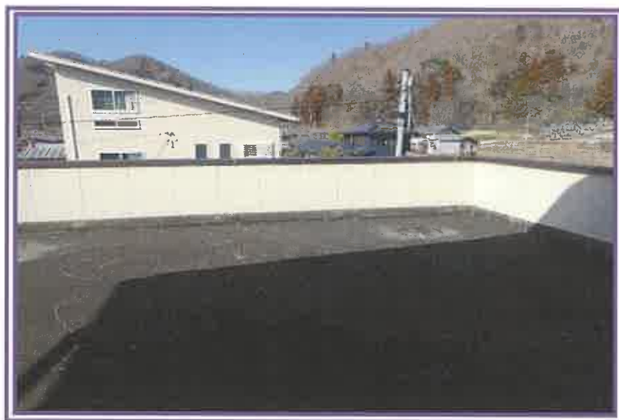
屋上 (物件12(居宅))
