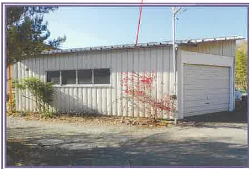
物件13附属建物 符号4(倉庫)
