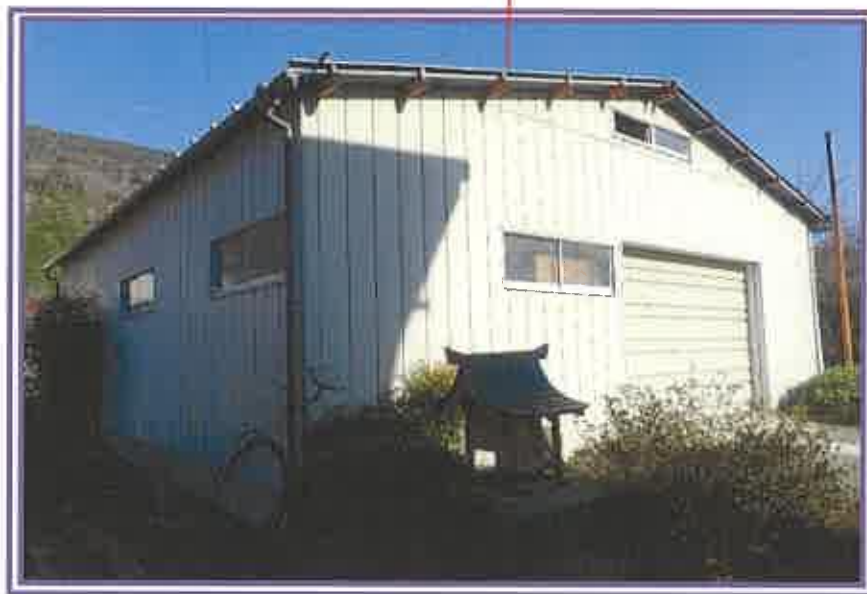
物件13附属建物 符号4(倉庫)
