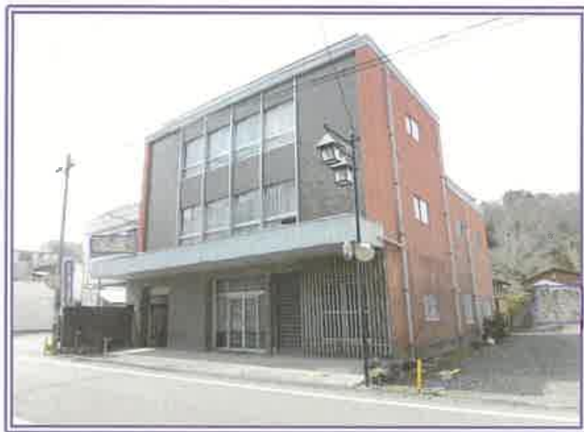
物件5（店舗・居宅）の正面近景
