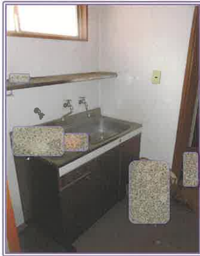
2階 給湯スペース
