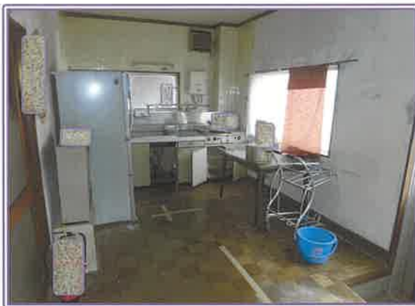
1階 台所（居宅内）
