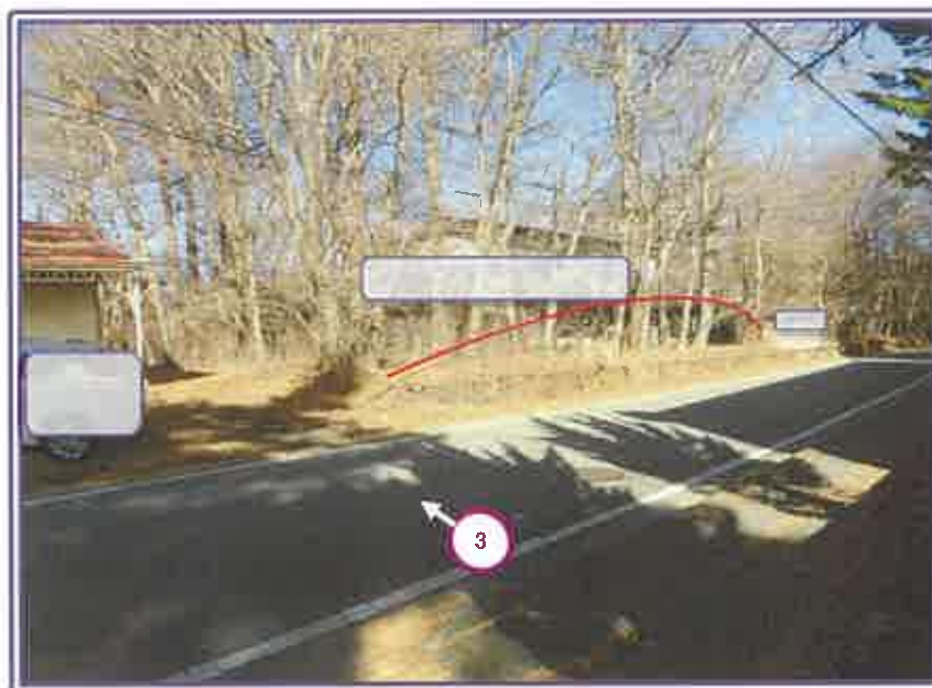
本件山林の広道側全景
