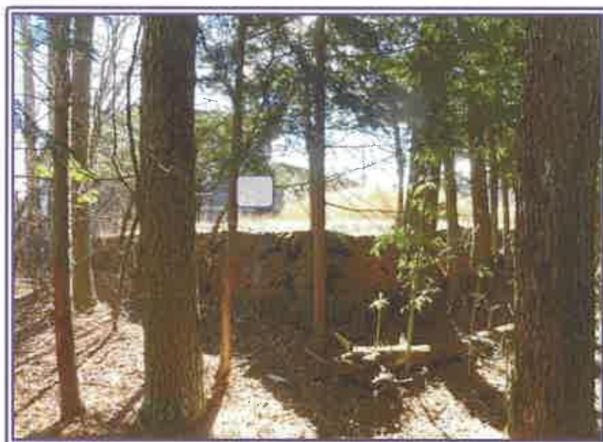
本件原野（概ね石垣上の土地）の北東角側近景
