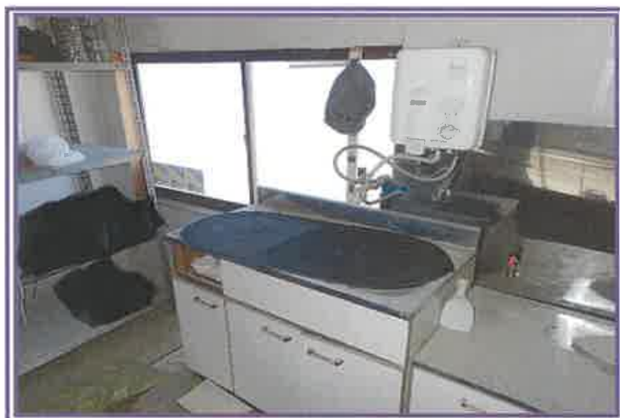
流し台付近を撮影したもの(事務室)
