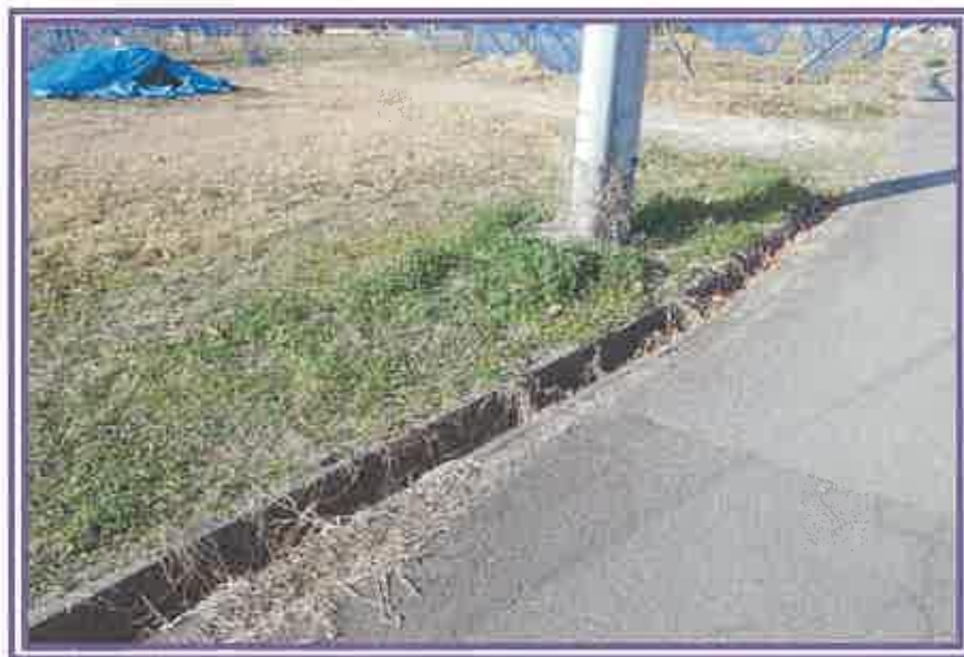
物件3の土地の東側に、U字溝が設置されている状況を撮影したもの
