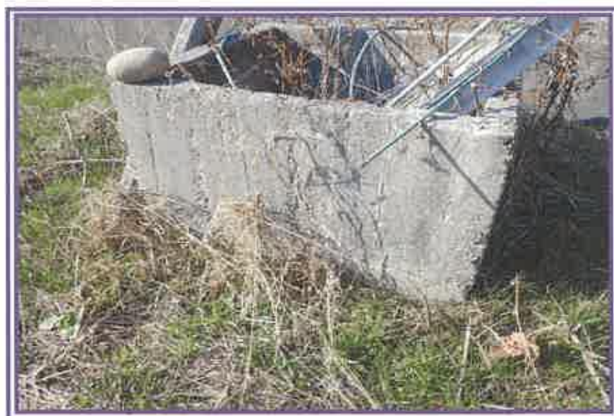
物件4の土地上に置かれているコンクリート製の柵(定着性なし)を撮影したもの
