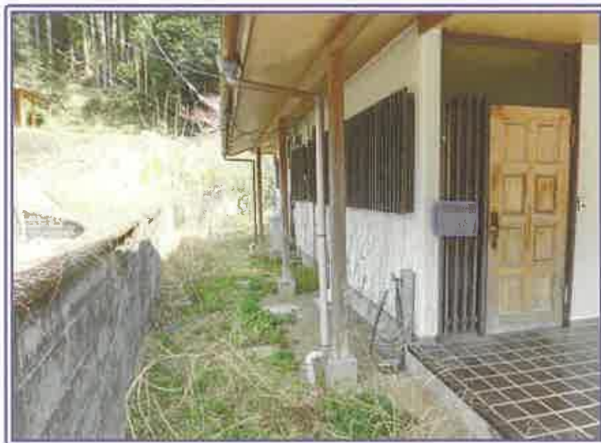
建物脇の敷地内の状況
