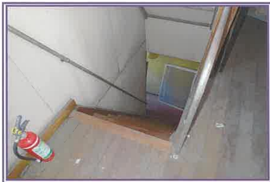
3階から、南西側階段方向を撮影したもの(物件7居宅、浴場)
