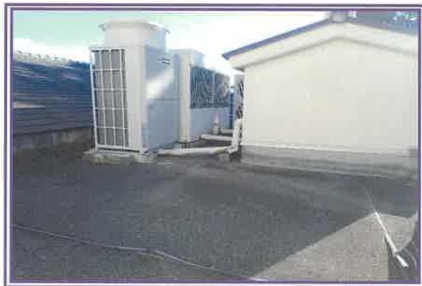
4階機械室付近から、屋上部分を撮影したもの(物件11旅館)
