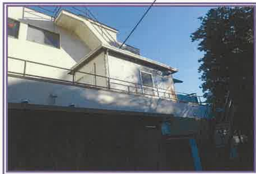
物件11(旅館)2階屋上に設置されている物置及びその周辺を撮影したもの
