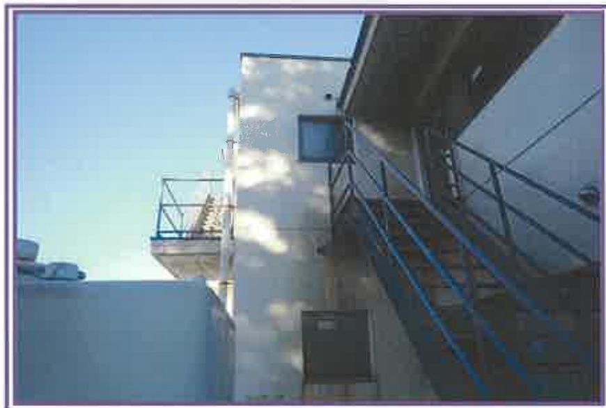
2階屋上から、外階段方向を撮影したもの(物件11旅館)
