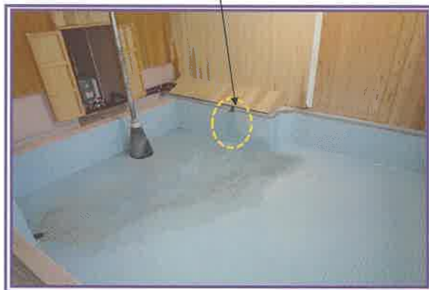
地下1階にある浴槽(男性用)を撮影したもの(物件7住宅, 浴場)
