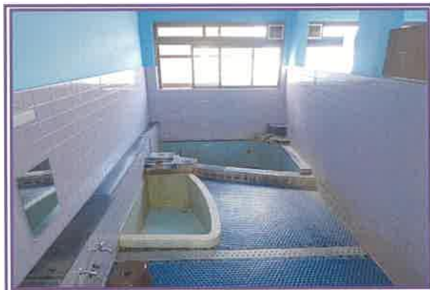
男性用1階浴場 (物件7居宅, 浴場)
