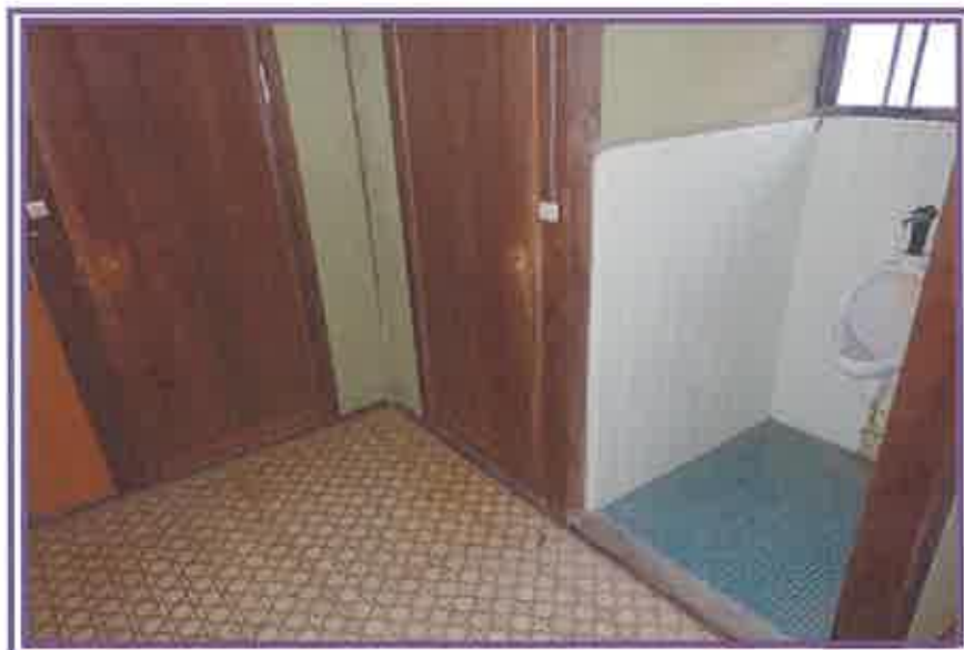
1階南西側便所 (物件7居宅, 浴場)
