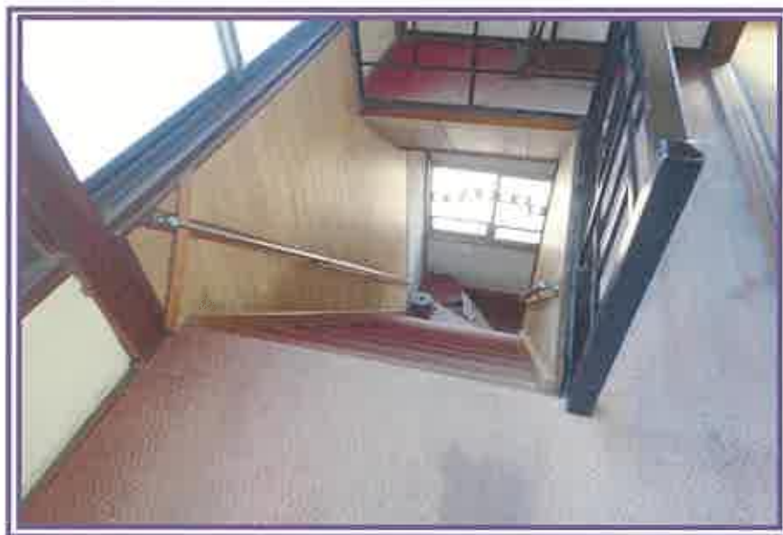
2階から、北東側階段方向を撮影したもの(物件7居宅, 浴場)
