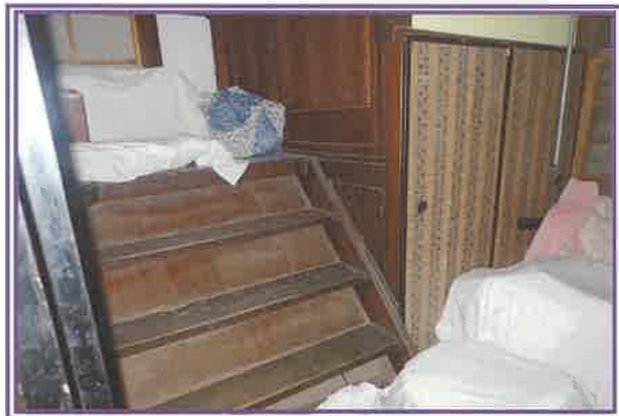
1階から、西側階段方向を撮影したもの(物件7居宅, 浴場)
