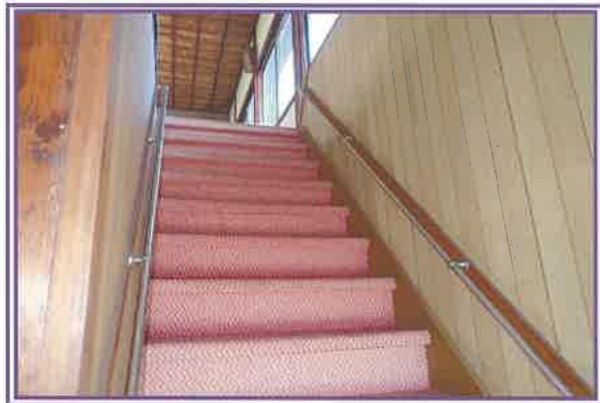
1階から, 北東側階段方向を撮影したもの(物件7居宅, 浴場)
