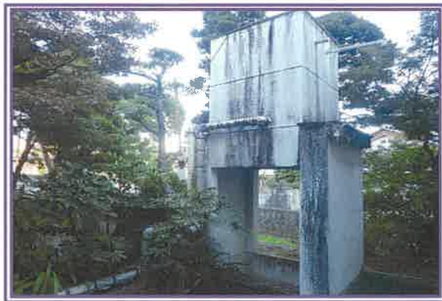
源泉汲上げ設備及びその周辺を撮影したもの
