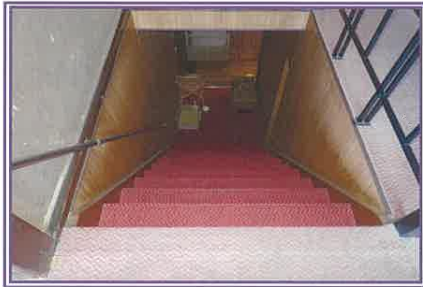
2階から、北側中央階段方向を撮影したもの(物件7居宅、浴場)
