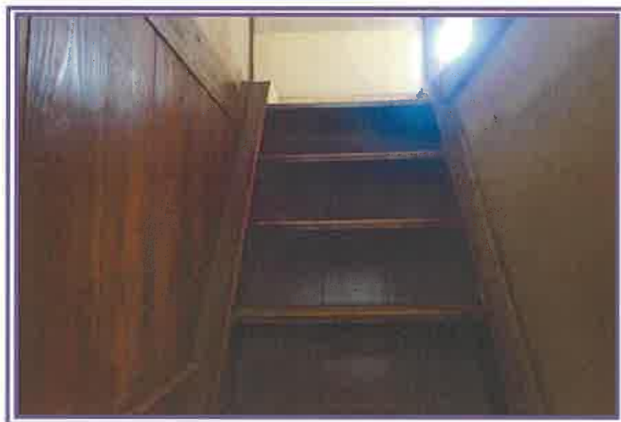
1階から、居宅2階部分へと通じる階段方向を撮影したもの(物件7居宅、浴場)
