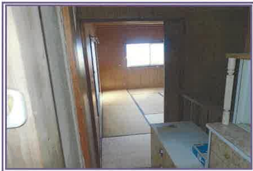
2階通路から、物件7附属建物符号2(居宅)方向を撮影したもの(物件7居宅、浴場)
