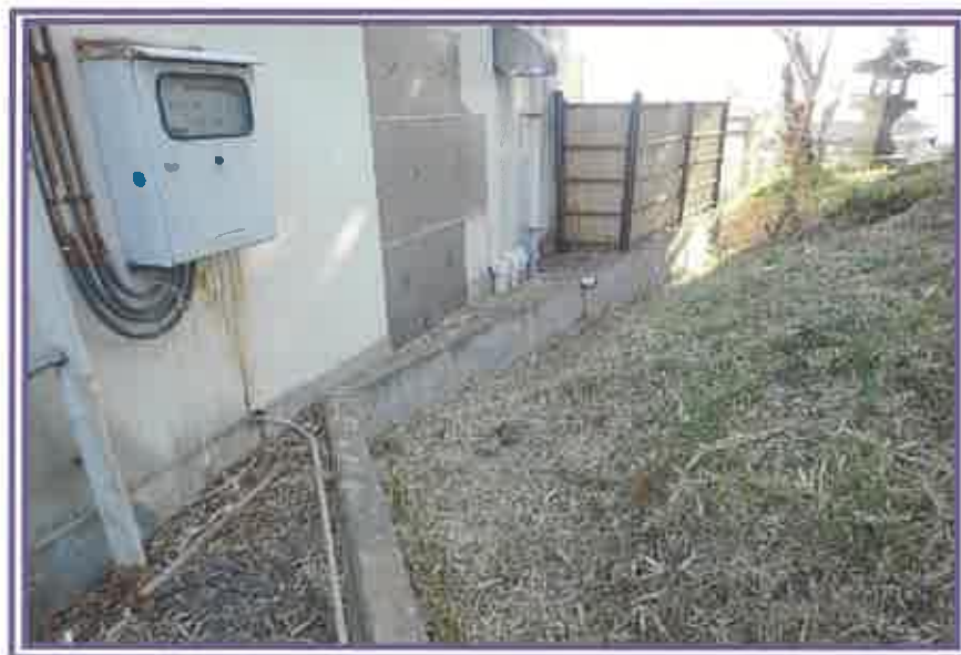
新館(物件11)敷地の南側境界付近に土留めが設置されている状況を撮影したもの
