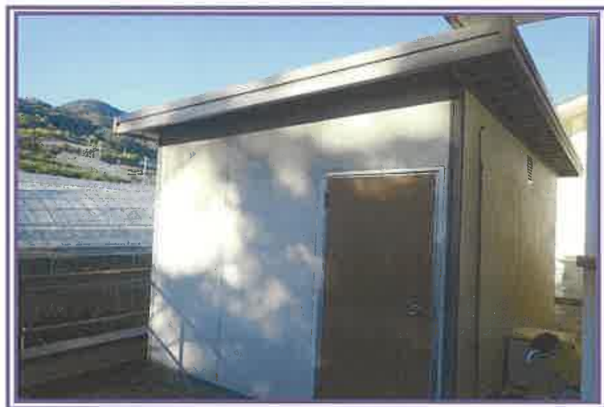
物件11旅館の2階屋上に設置されている物置
