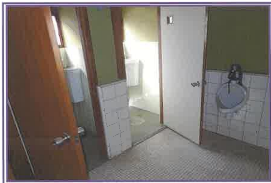
2階トイレ (物件7居宅, 浴場)
