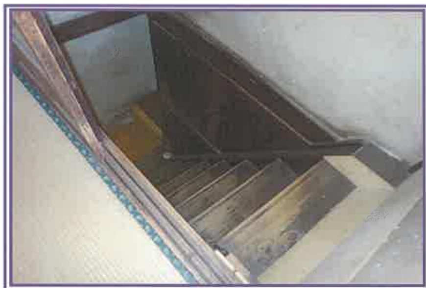
2階から、居宅1階部分へと通じる階段方向を撮影したもの(物件7居宅、浴場)
