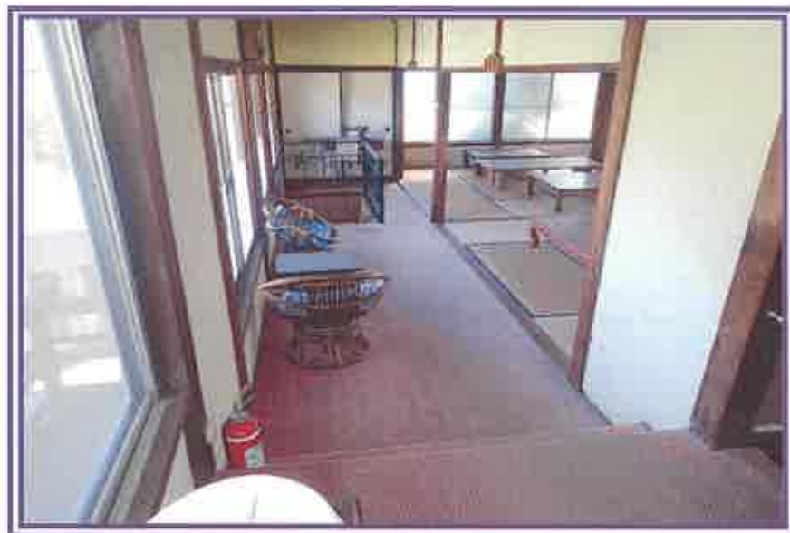
2階北側廊下及びその周辺を撮影したもの(物件7居宅, 浴場)
