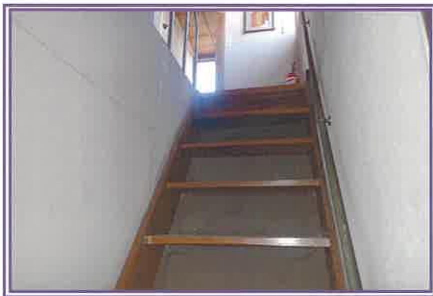
2階から、南西側階段方向を撮影したもの(物件7居宅、浴場)
