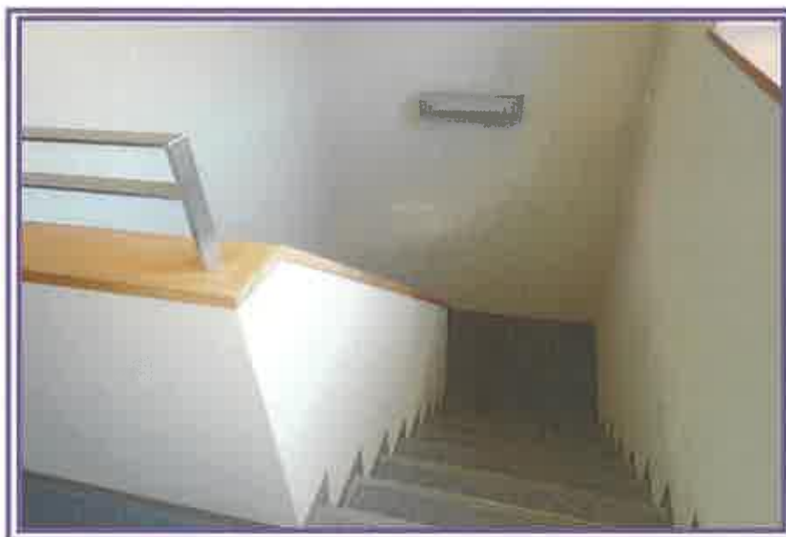
3階から、階段方向を撮影したもの(物件11旅館)
