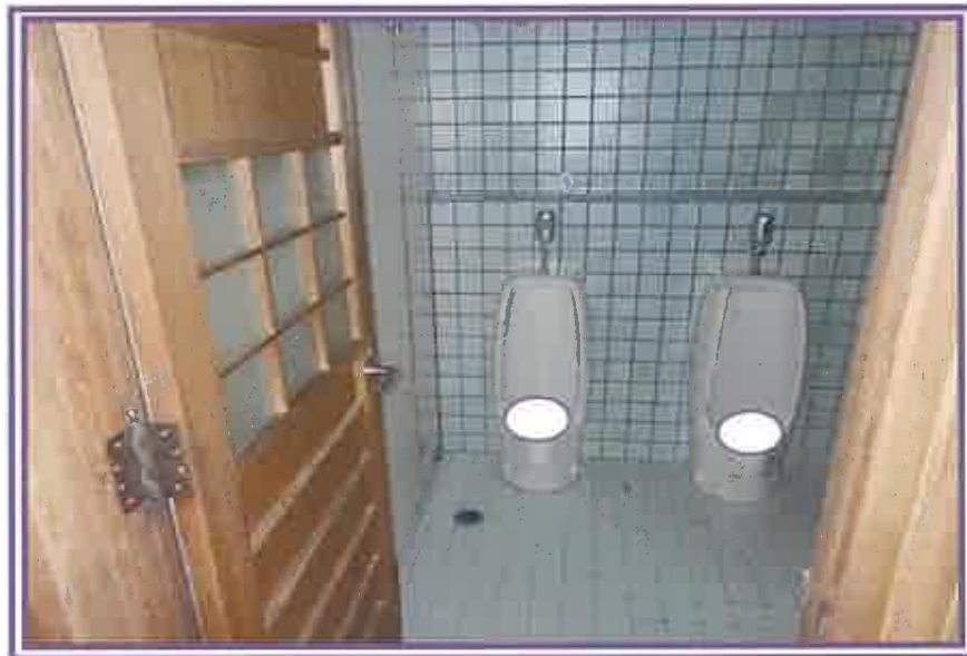
1階南側トイレ (物件11旅館)
