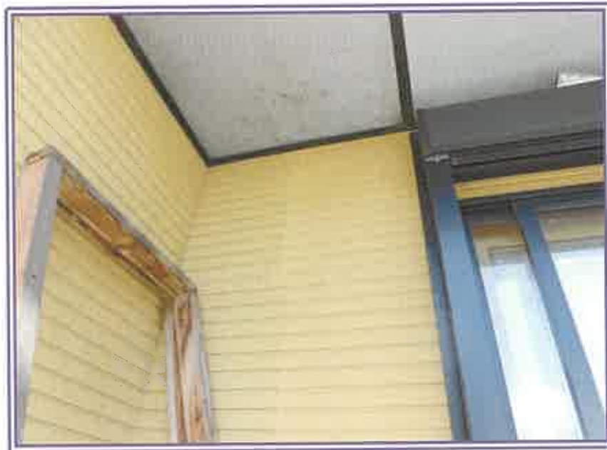
外壁の補修跡（中央）と二重窓（右）
