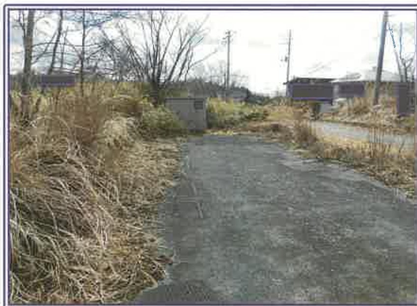
汚水処理制御室（奥）とアスファルト敷（本件土地内）
