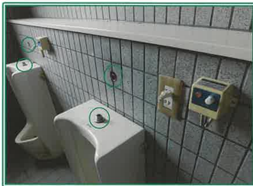
トイレ（北棟・1階）
