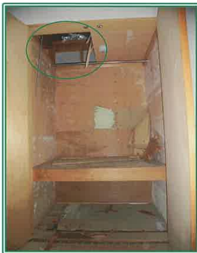
従業員休憩室内の押入
