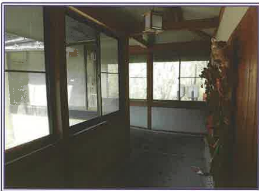
北棟（奥）への渡り廊下（南棟）
