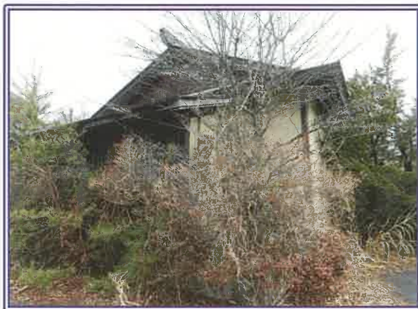
南棟の西側近景
