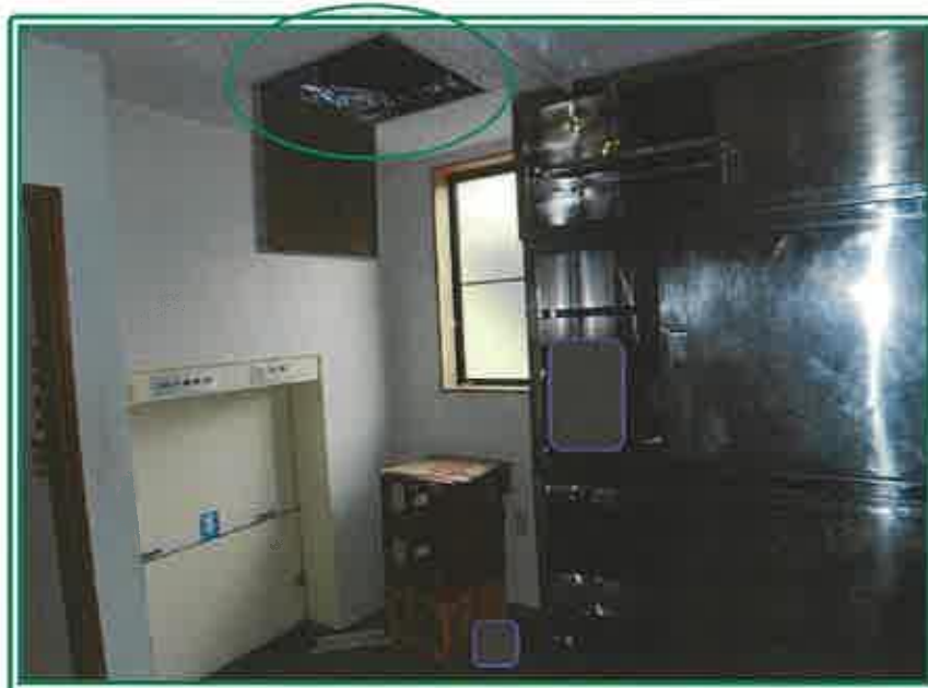
配膳室(北棟・2階)
