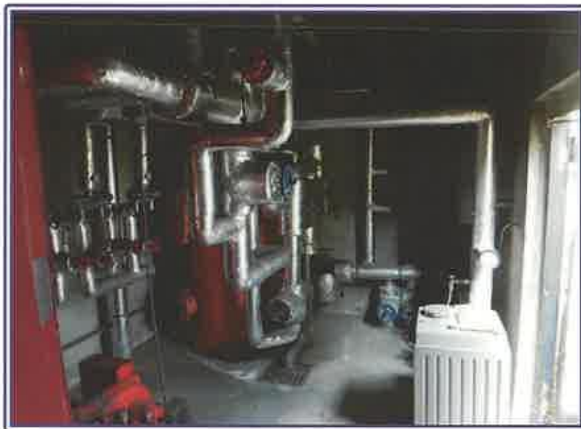
ボイラー室（南棟）
