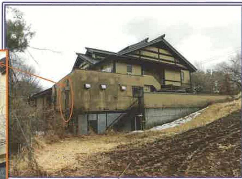
北棟の北側遠景
