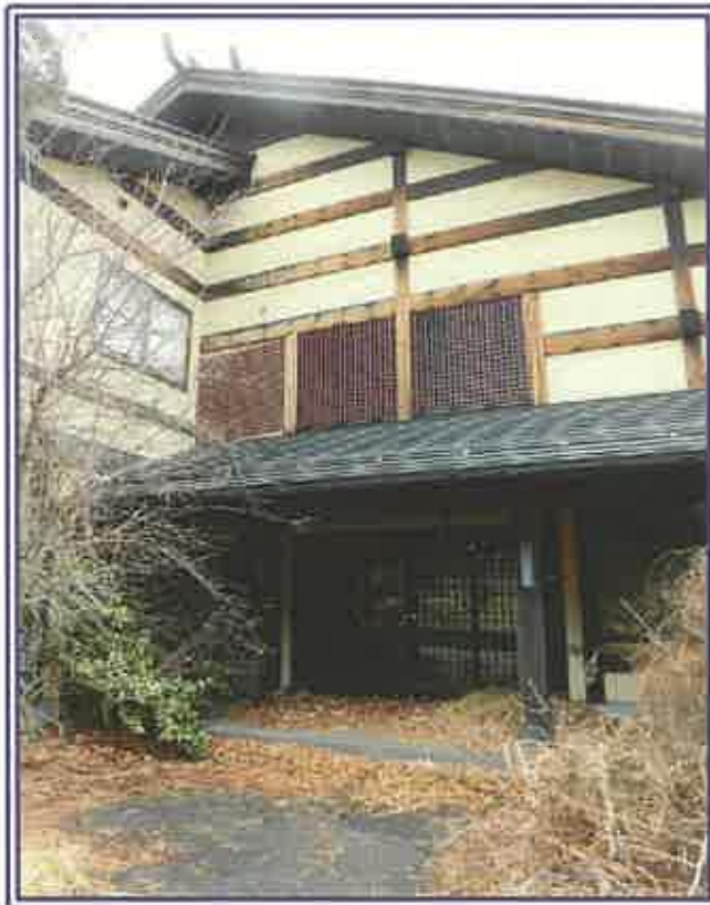
北棟のエントランス 付近
