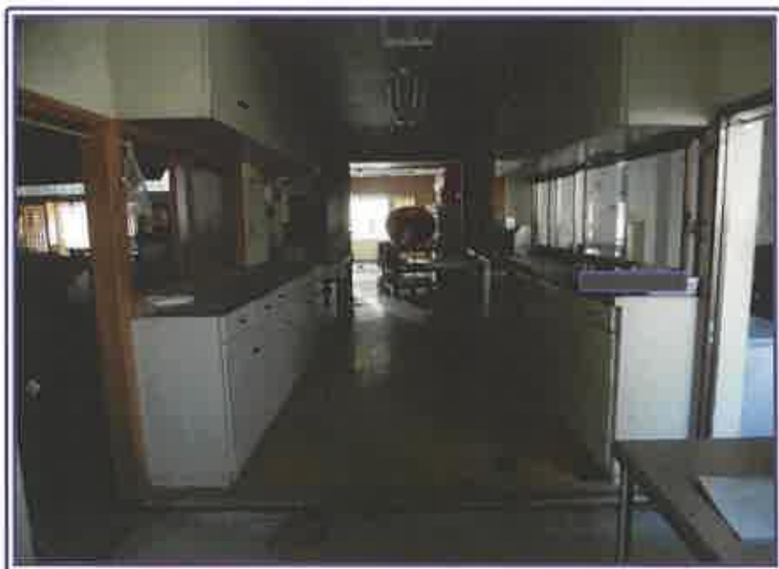
配膳スペース（北棟・1階）
