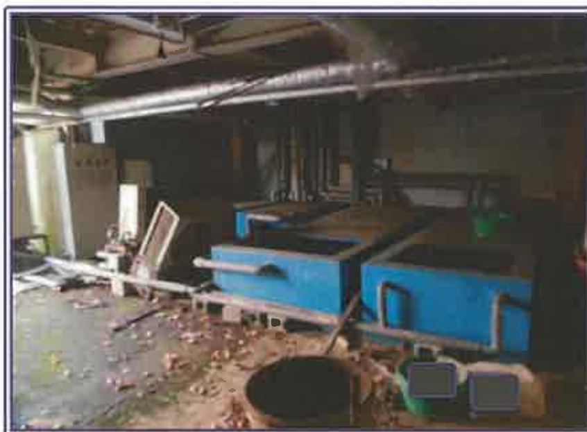
いけす置場（北棟・地下1階）
