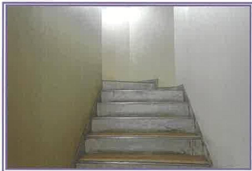
地下1階から、西側階段方向を撮影したもの
