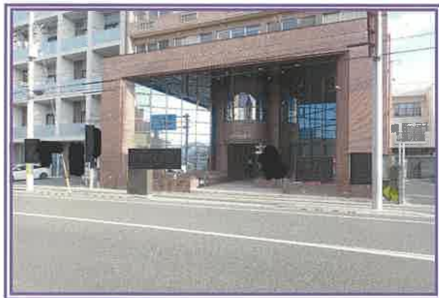
エントランス付近を撮影したもの
