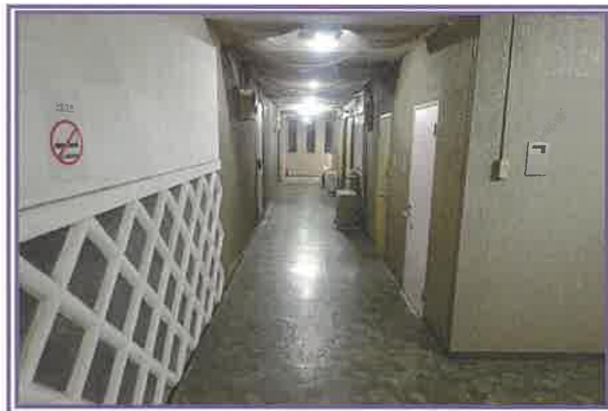
地下1階の廊下(通路)
