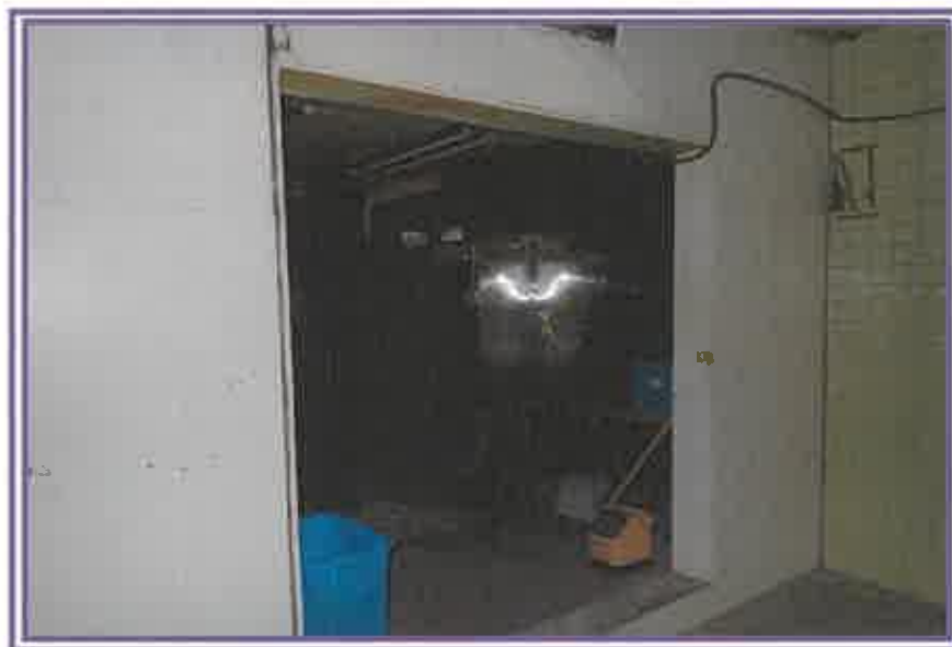
002号室内(間取図中の「厨房2」)から、本件区分所有建物 (地下1階003号室)との接合部付近を撮影したもの
