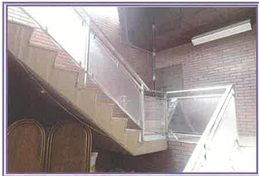
地下1階から、南側階段方向を撮影したもの
