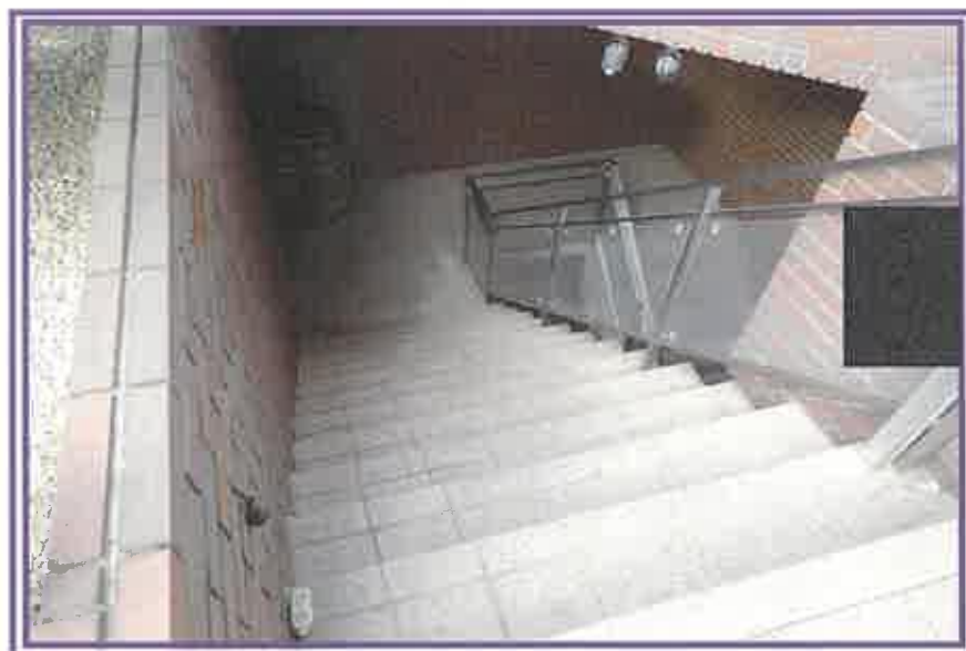
1階から、南側階段方向を撮影したもの
