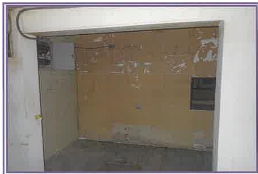
本件区分所有建物内(間取図中の「厨房1」)から、隣接している002号室 との接合部付近を撮影したもの
