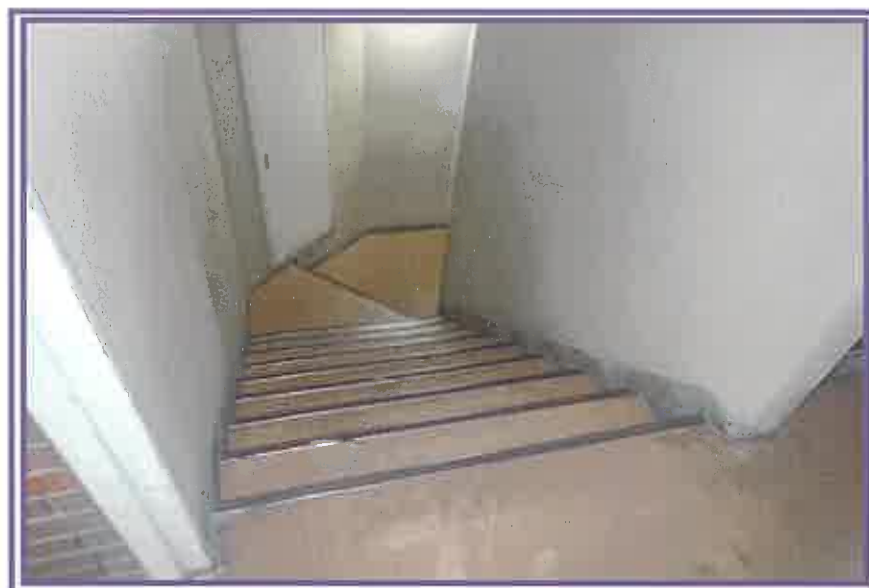
1階から、西側階段方向を撮影したもの
