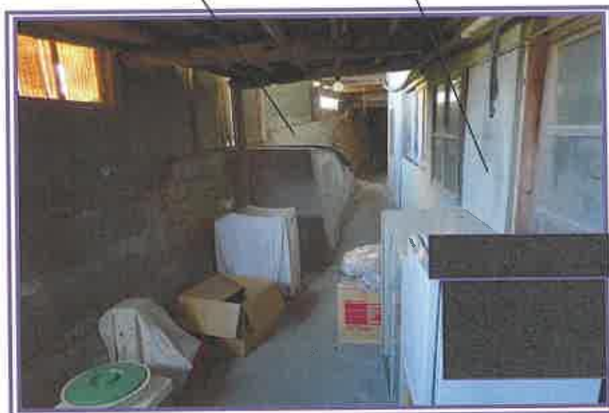
本件建物の外壁
