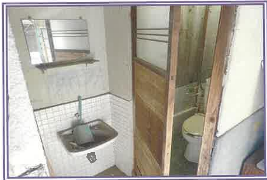
手洗い場所及びトイレ(屋上)
