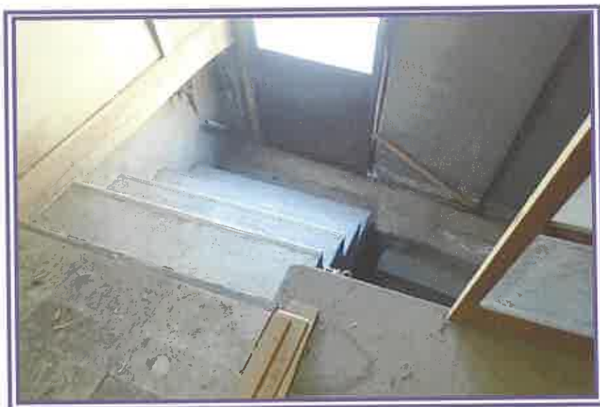
北側階段付近
