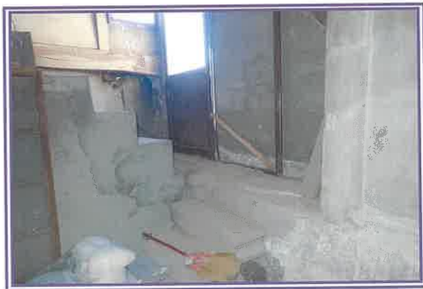
北側階段付近
