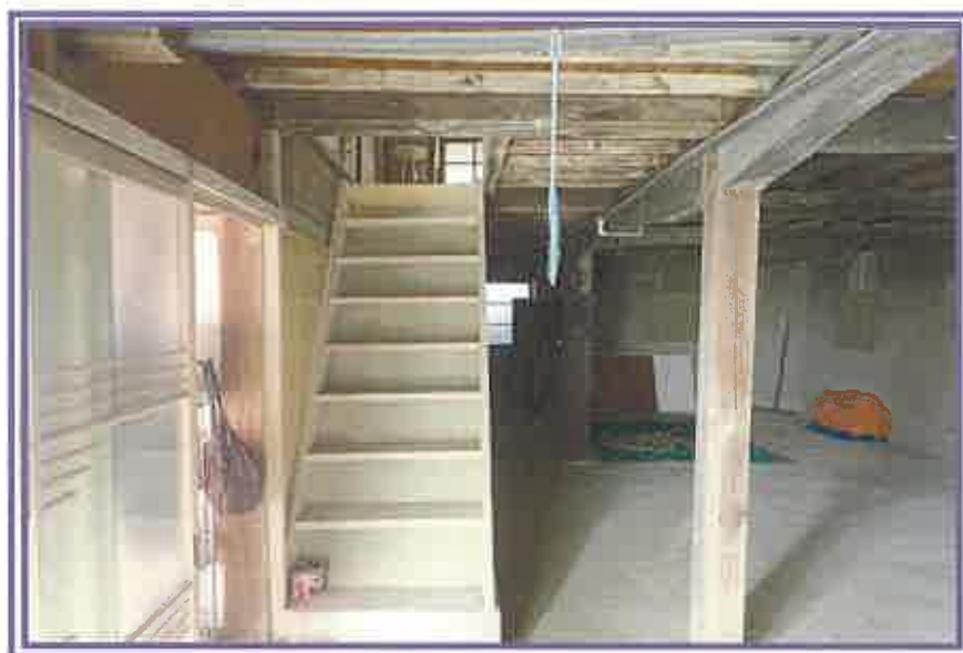
階段(東側)付近
