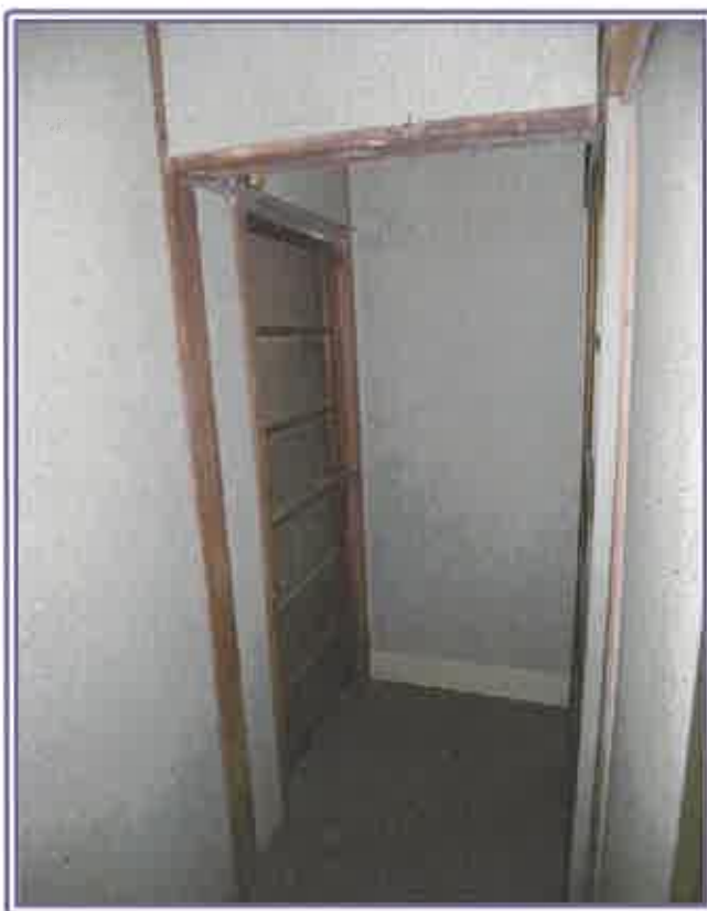
廊下（物件2の共同住宅）
