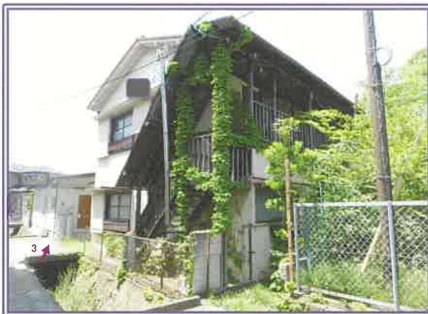
裏（会館）側 近景（物件2・共同住宅）
