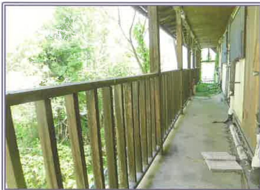
2階 各玄関前の状況（物件2・共同住宅）
