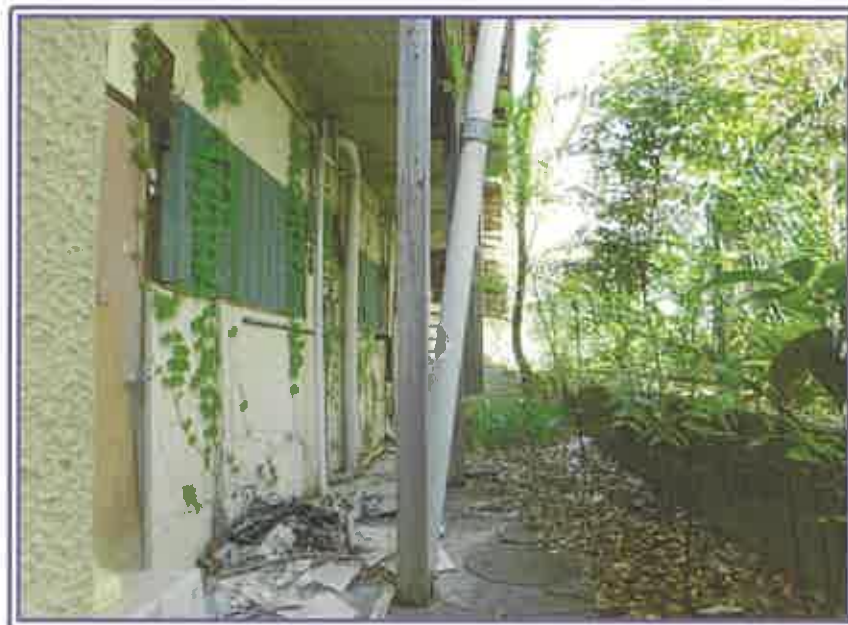
1階 各玄関前の状況（物件2・共同住宅）
