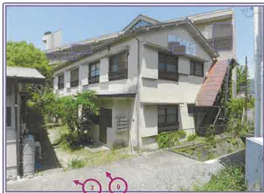
道（水路）側 近景（物件2・共同住宅）
