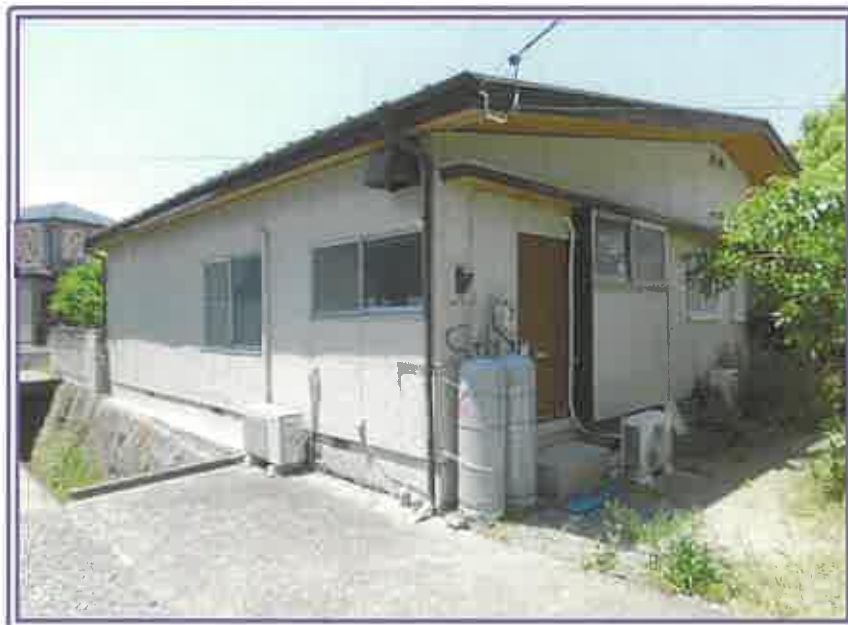
道（水路）側 近景（物件3・居宅）
