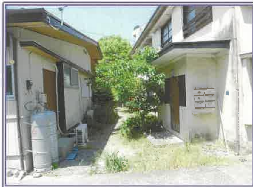
両建物間の敷地内の状況
